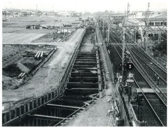
調査地全景(南から)
