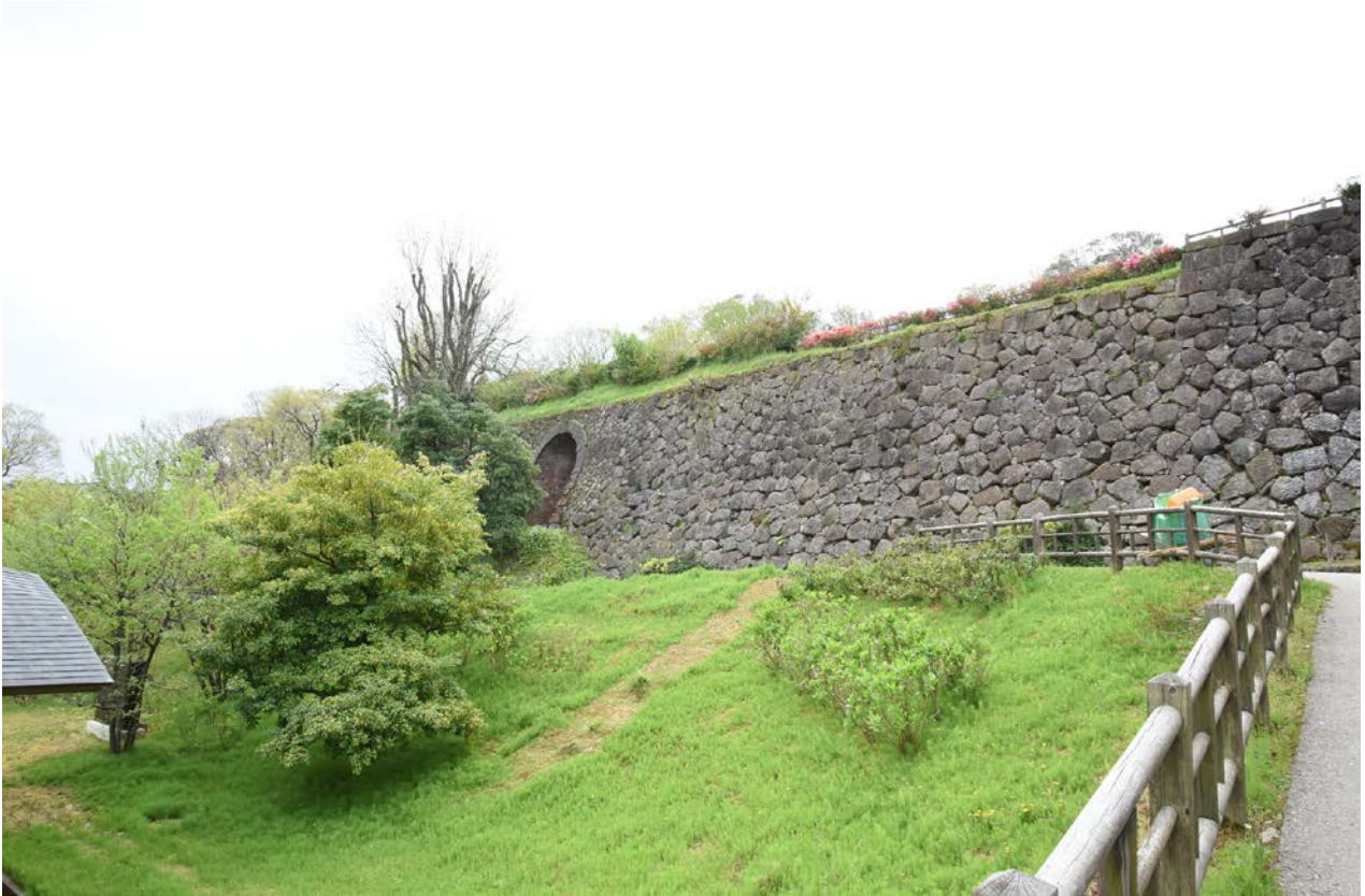
3. 1301N (北西から)
