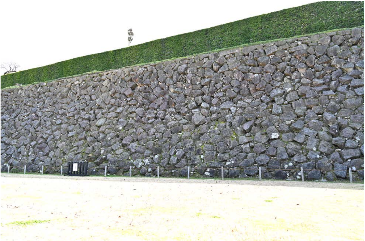
3. 3440N 中央部 (北から)
