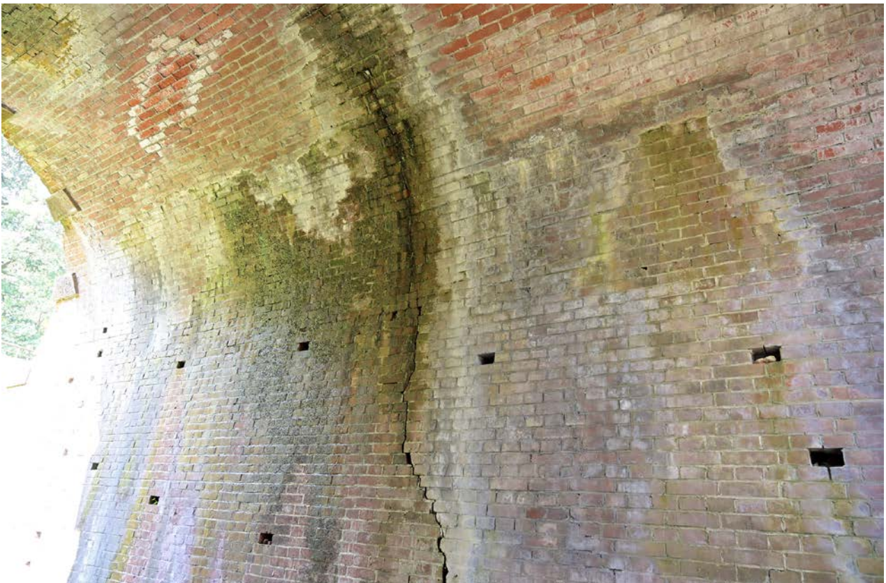
10. トンネル内のレンガ積（北から）
