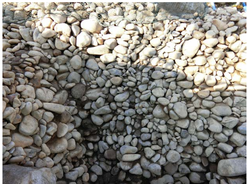
第136図 良好な裏込め 小峰城跡藤門
