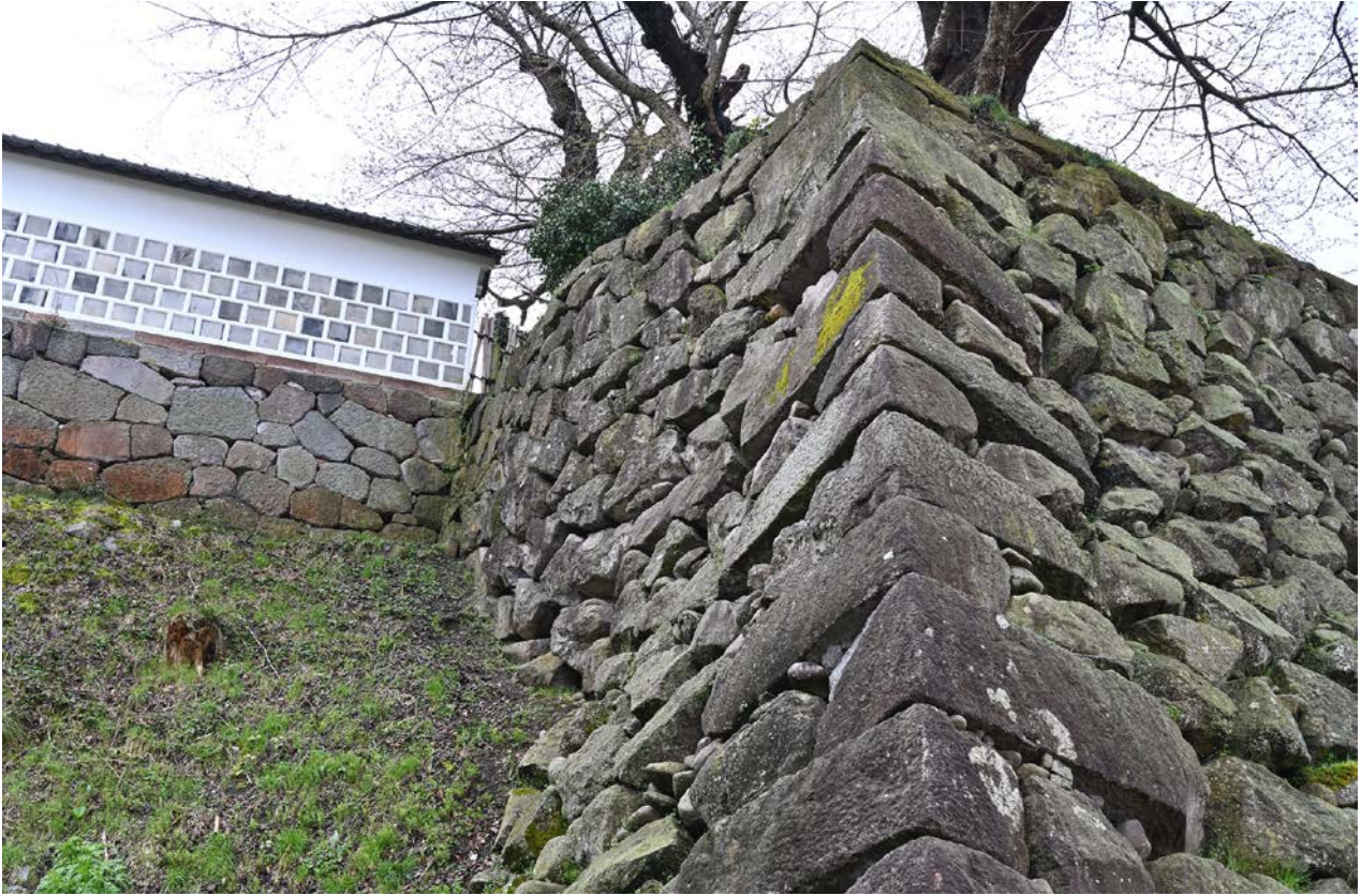
7. 3440E (北東から)
