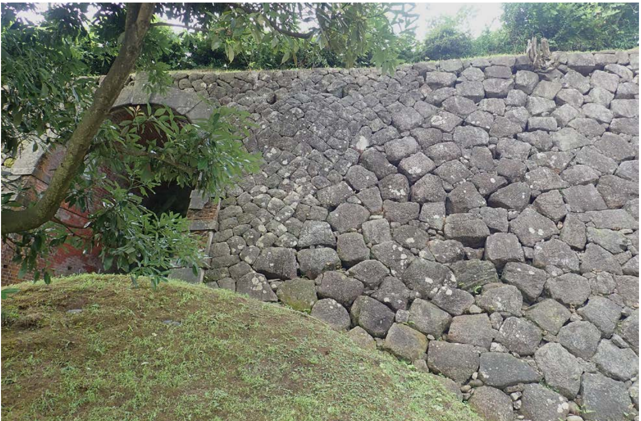
4. 1301N 弾薬庫 (北から)
