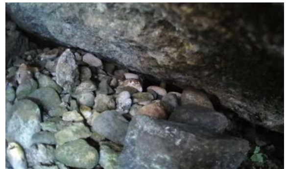
第134 図 石垣内部の施工状況 (上：菱槽、下：薪ノ丸北)
