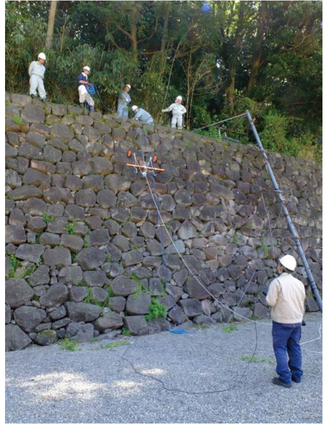
第 83 図 電磁探査作業風景
