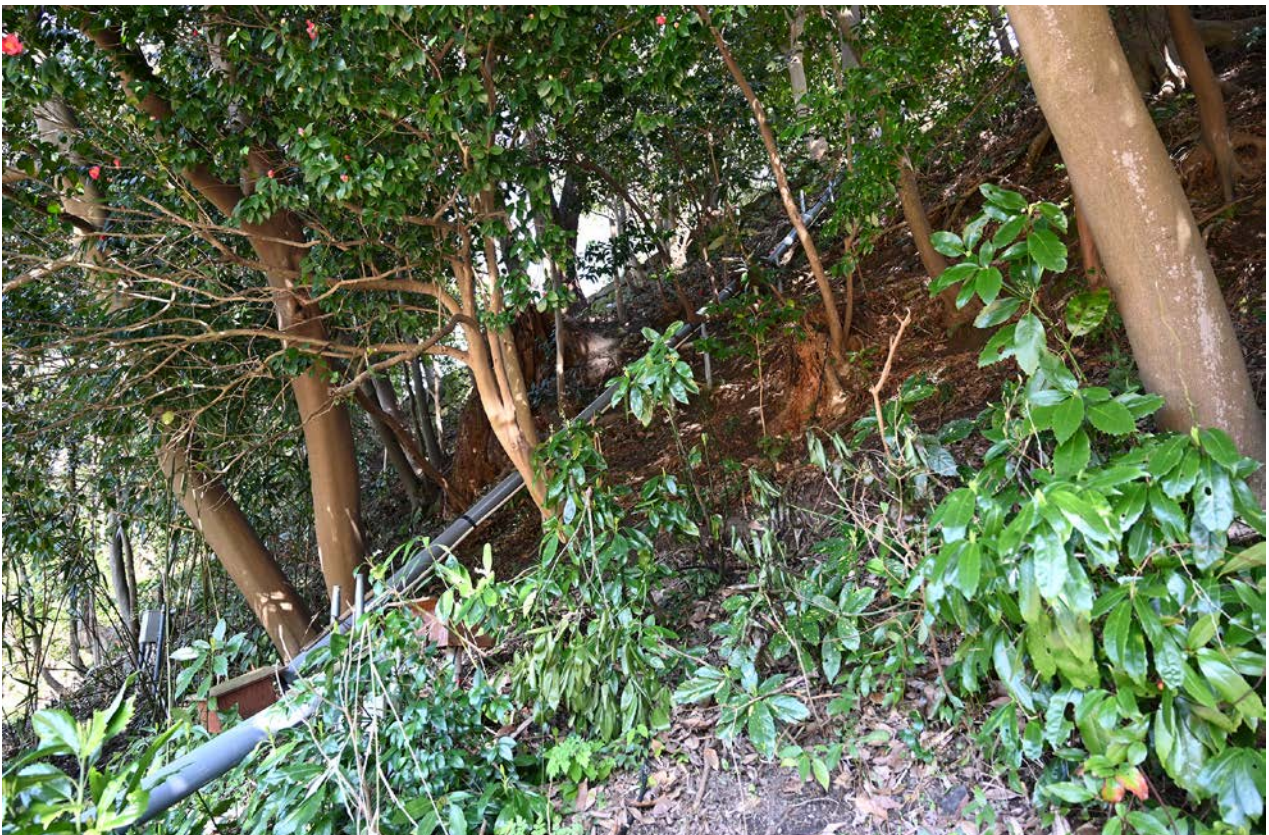
10. 伸縮計 (6500W背後の斜面のすべりを計測)
