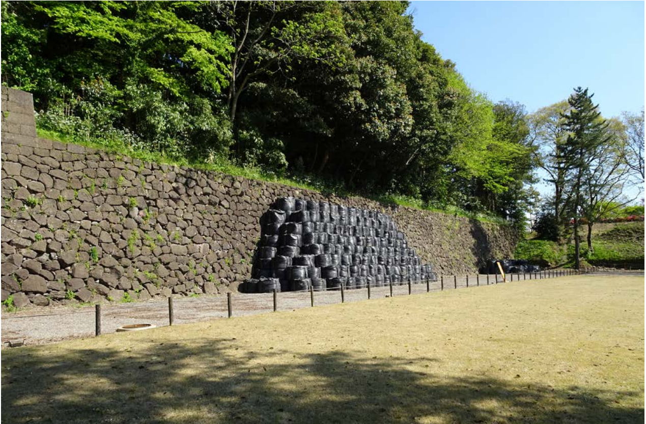
9. 6500W 大型土嚢設置 (2020年4月)
