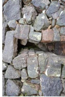
暗渠吐水口からみたら石積の崩落状況
