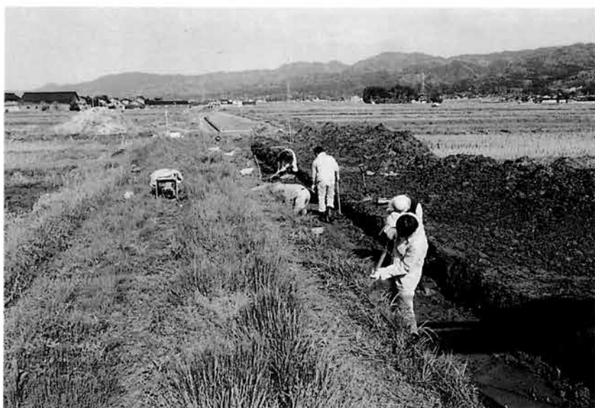
(3) 調査作業風景（西から）
