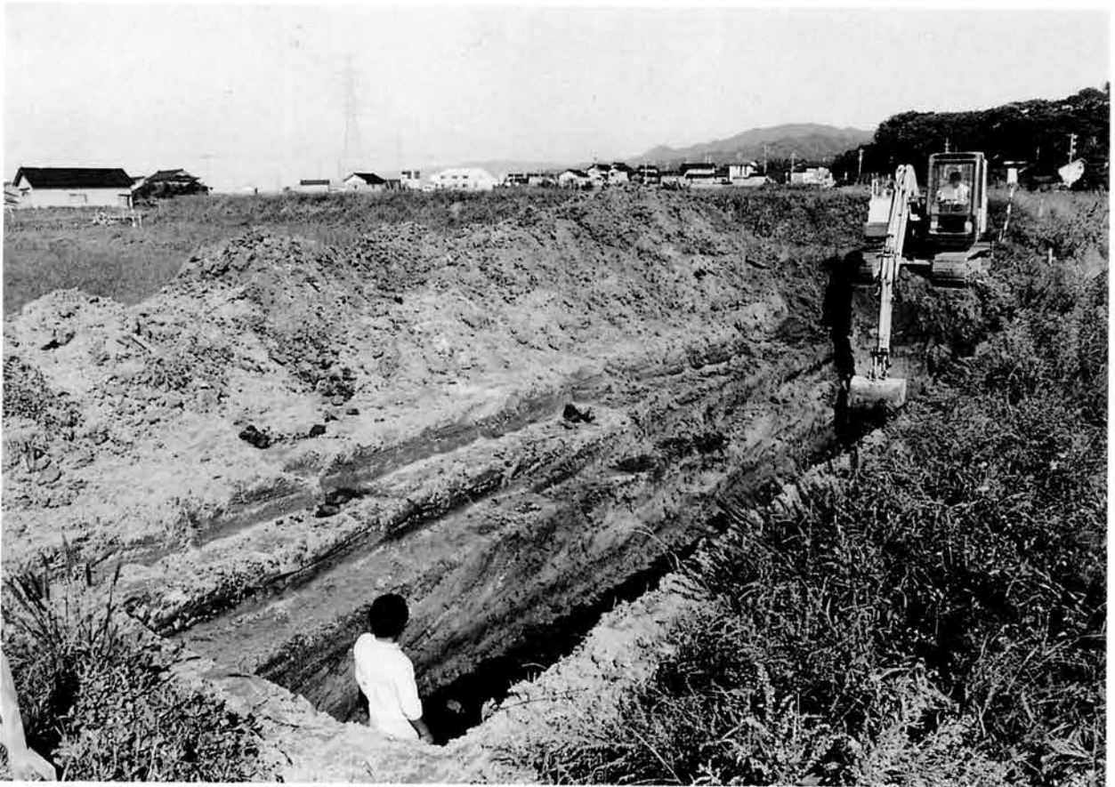
(2) B地区 第2区 (南西方より)
