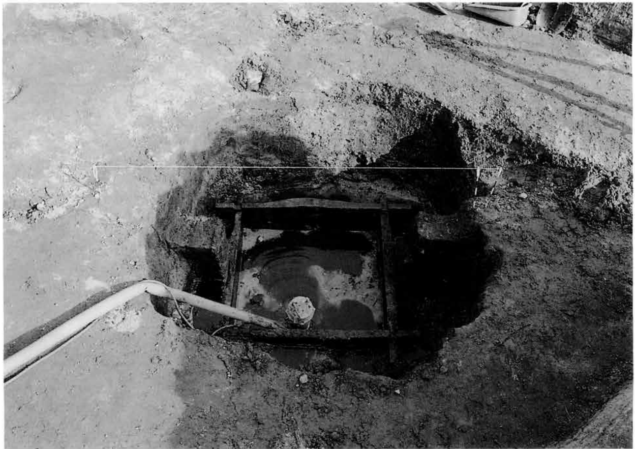
(2) 1号井戸掘り方(側財最下段を残した状態、南東から)
