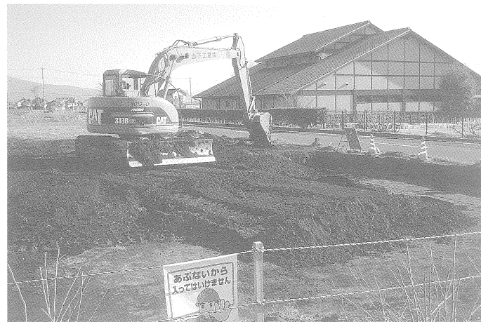
埋め戻し状況
