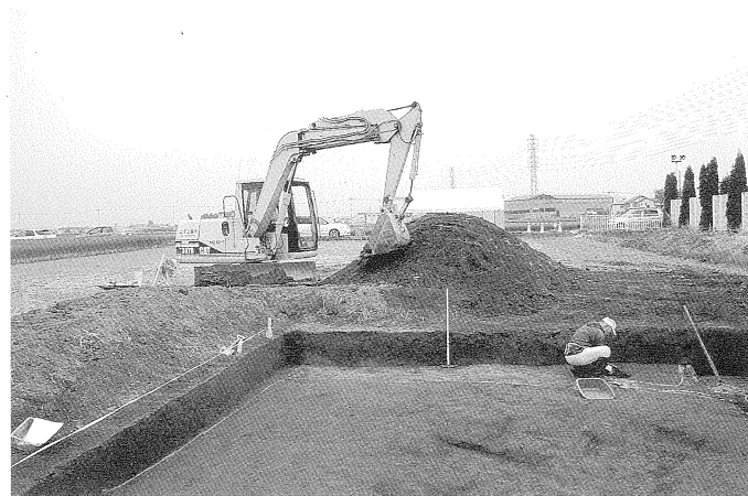
重機稼動状況 北から
