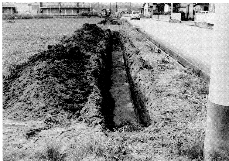
9. 岩井諏訪前 トレンチ⑥・⑦ (北→)
