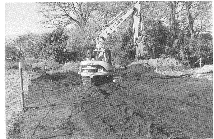
埋め戻し状況 東から
