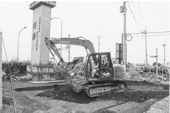
埋め戻し状況 南東から
