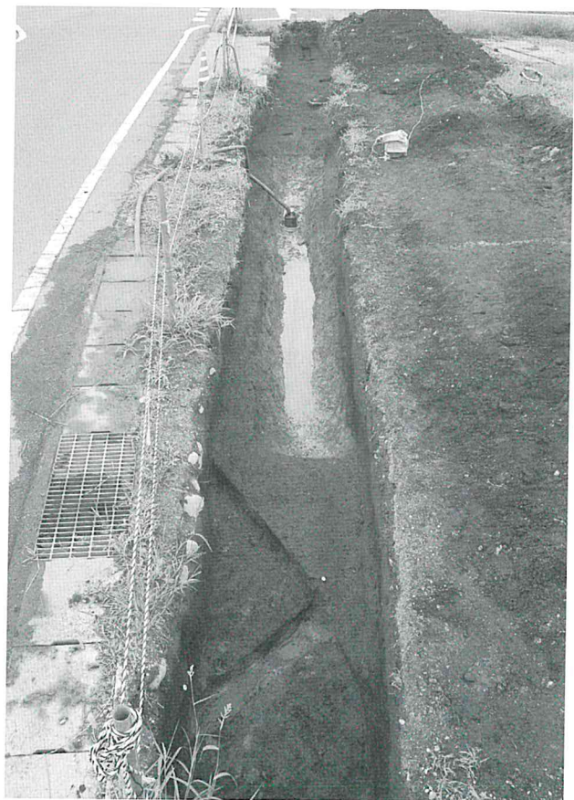
B区第2面完掘状況全景(北→)
