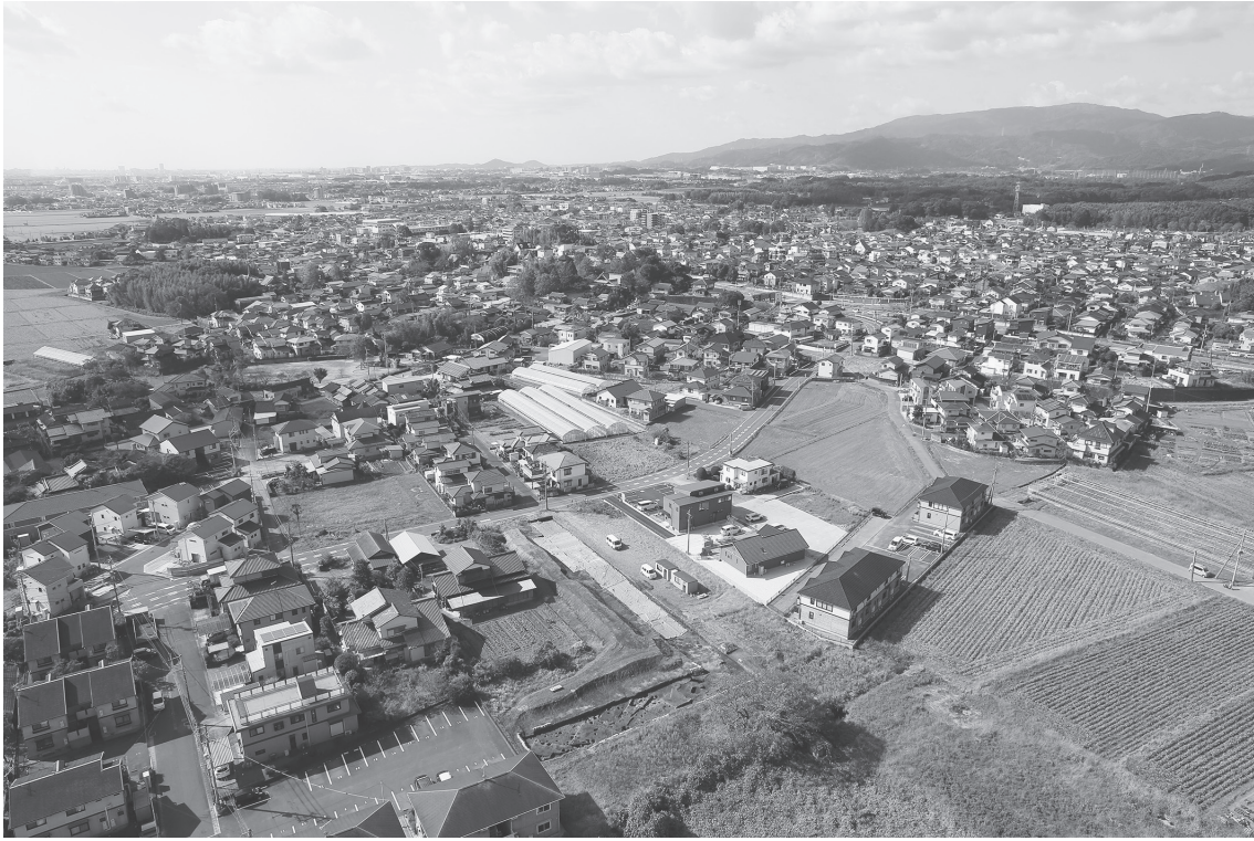
①調査区遠景（北東から）
