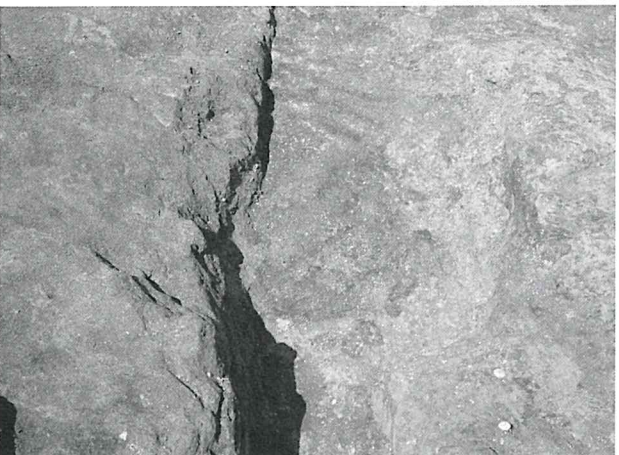
SK-08 全景 南西から
