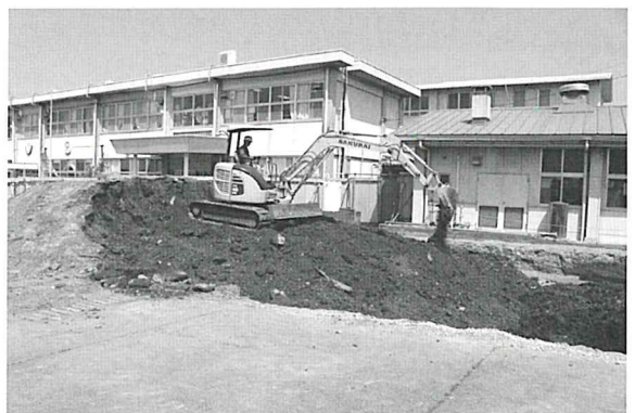
調査区反転作業 (南から)
