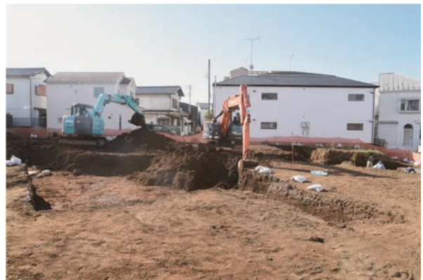
4. 調査区西部表土剥ぎ（東から）
