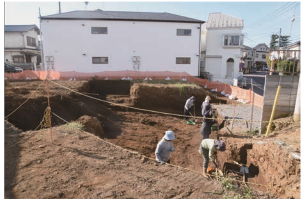
6. 西部プラン確認精査（東から）
