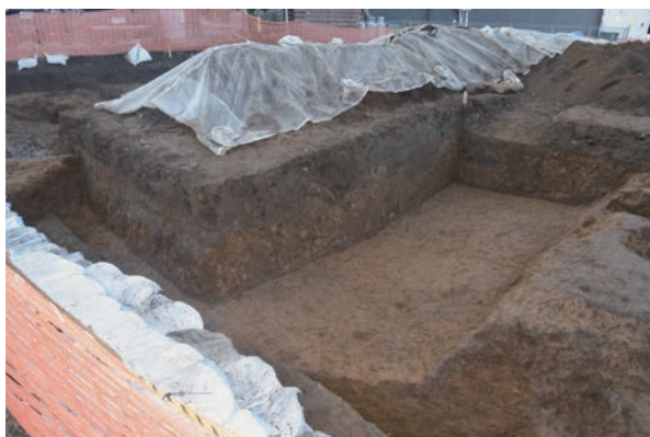
7. 2号段切状遺構完掘 (北東から)
