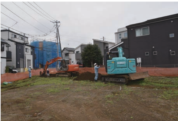
3. 調査区東・中央部表土剥ぎ（北から）
