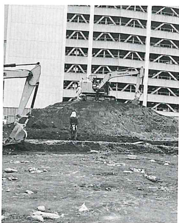
常時2台のバックホウで土を移動
