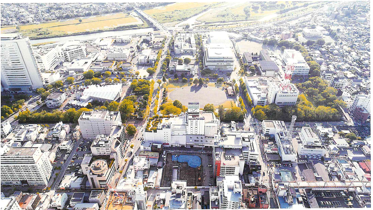
調査区上空から見た高崎城（東から）
