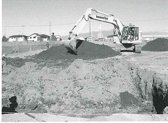
調査区盛土掘削 2
