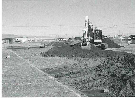
調査区盛土掘削 1
