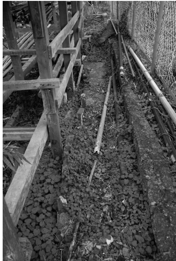
写真32 弘道館北限西側の現況（西から）
