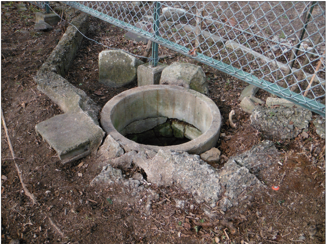
8 藩校弘道館 講堂跡付近に残る井戸（南から撮影）
