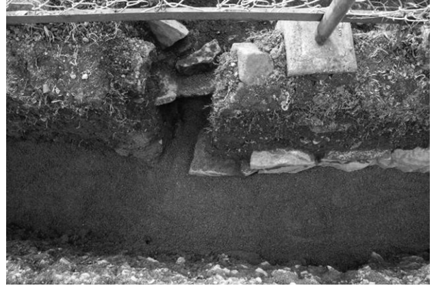
写真83 T12石垣遺構養生状況（東から）
