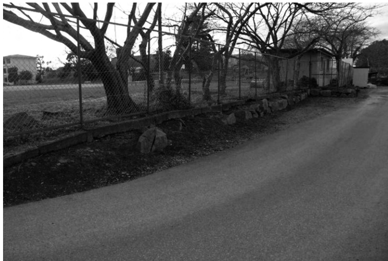
写真29 弘道館北限東側の石垣遺構（東から）
