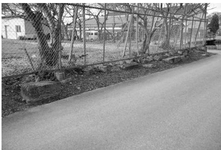
写真36 東限北側の石列状遺構（南東から）
