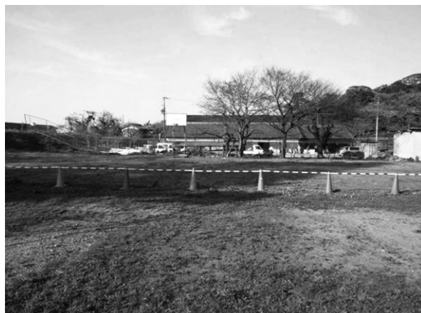
写真65 T10埋戻し完了状況（南から）
