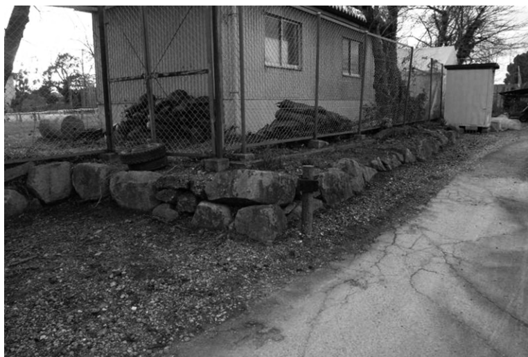
写真30 弘道館北限東側の石垣遺構（クランク部分、東から）
