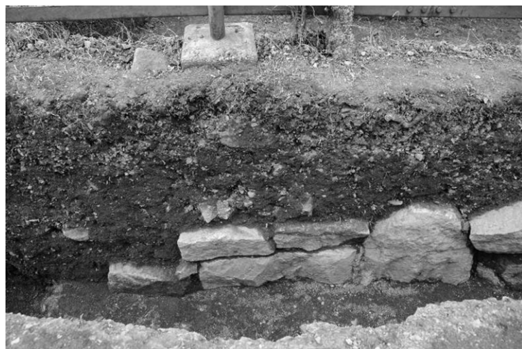
写真78 T12南東隅石垣攪乱状況（東から）
