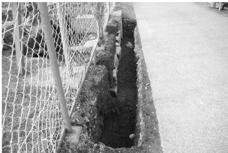
写真74 T12南東隅石垣検出状況（南から）
