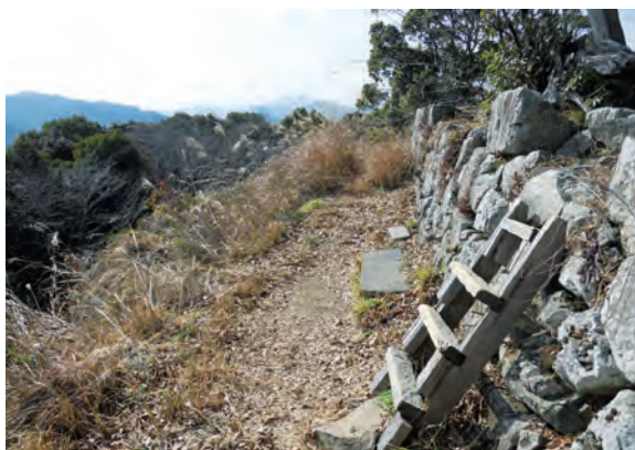
西出丸南端の犬走り 東から
