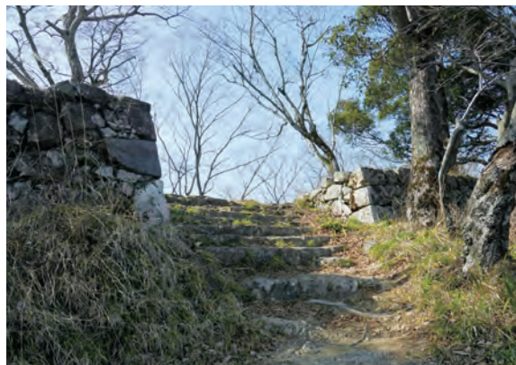
西出丸虎口 南東から
