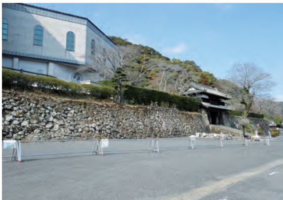
三の丸石垣全景 南から
