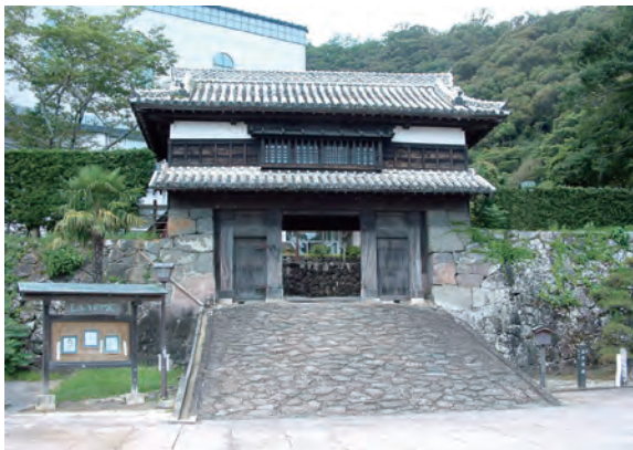
三の丸櫓門 南東から
