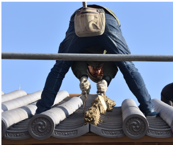
美装化工事 本瓦屋根補修工事
