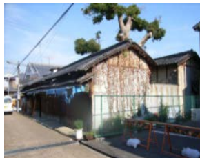
【西側建物：着手前】
