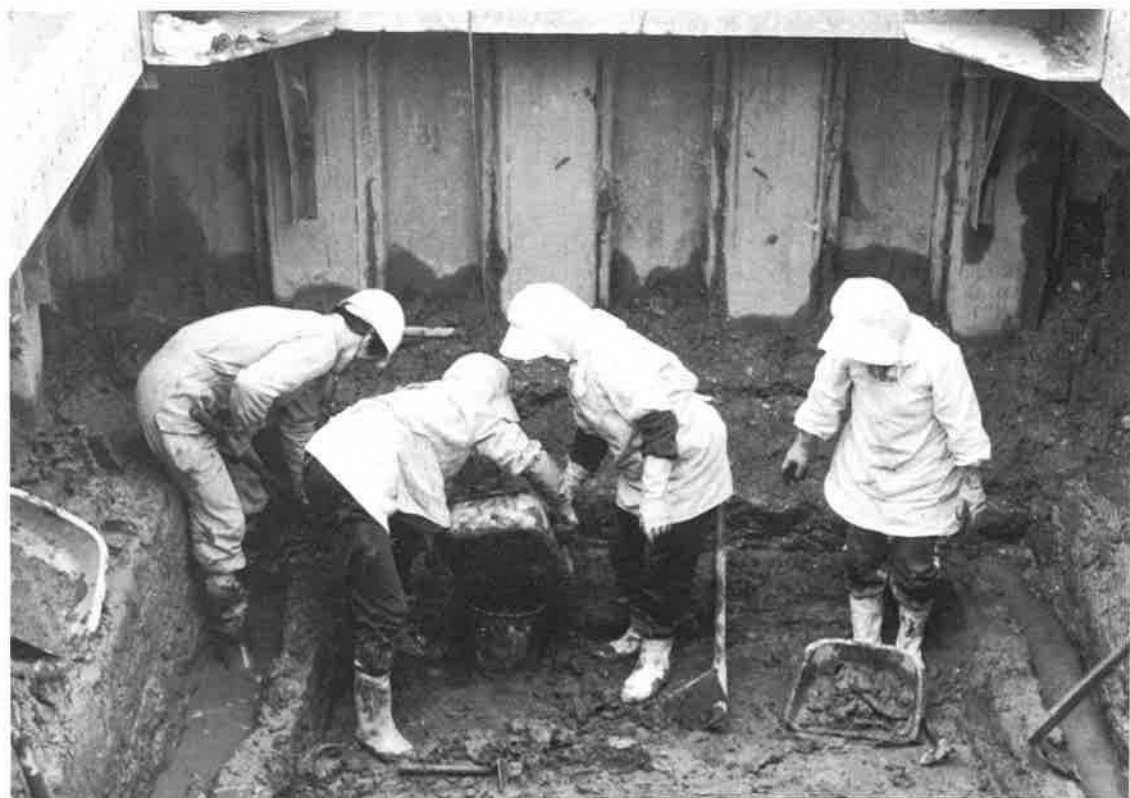
(2)調査作業状況
