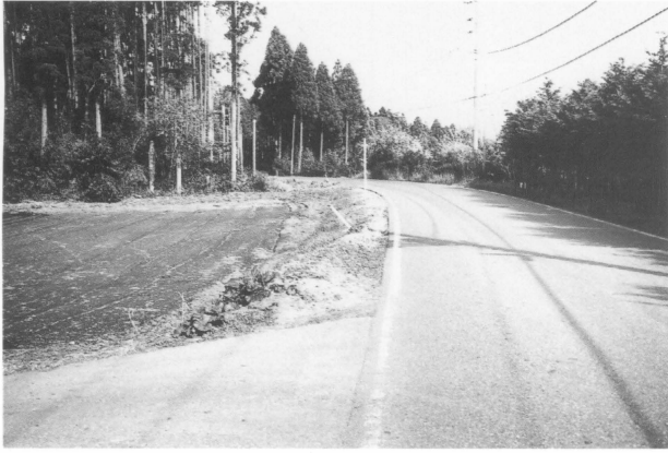
調査区北から
