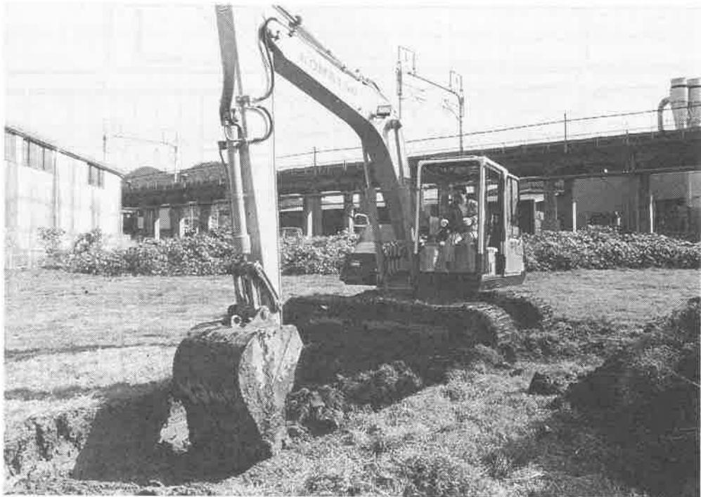
写真1 重機による表土掘削
