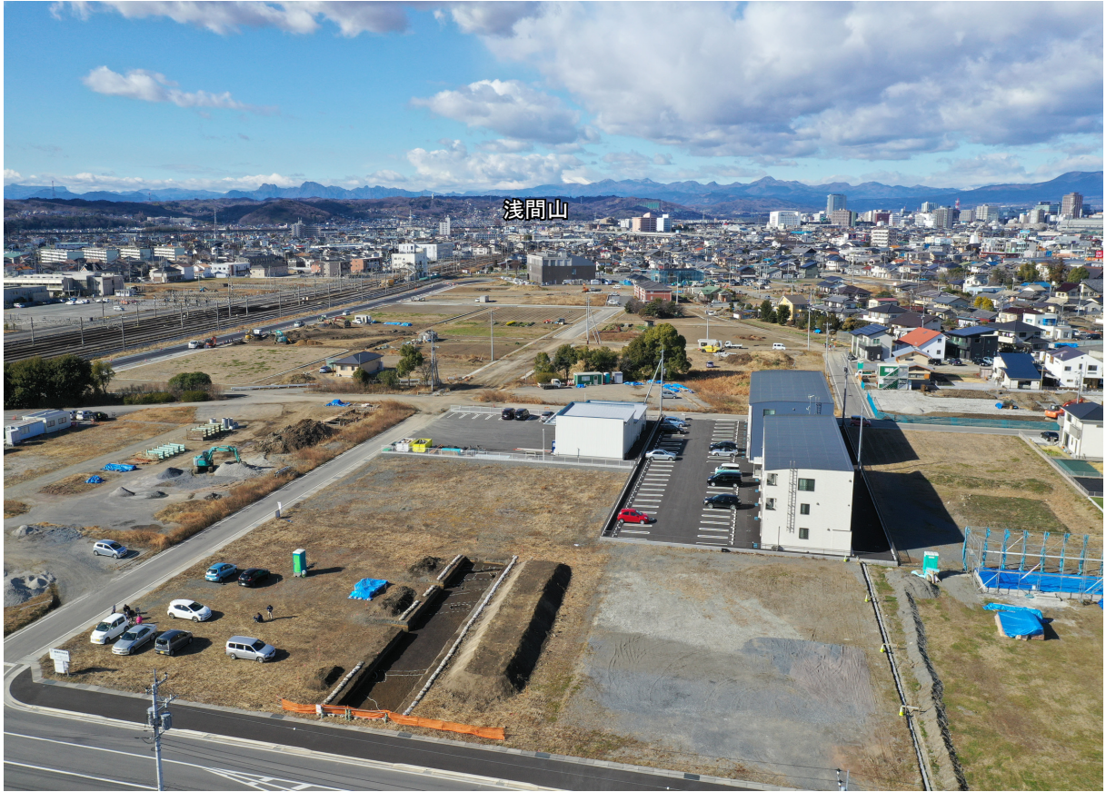
調査区遠景（東から）
