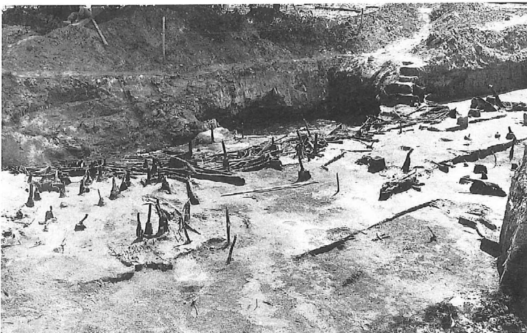
左岸の上流からみる
