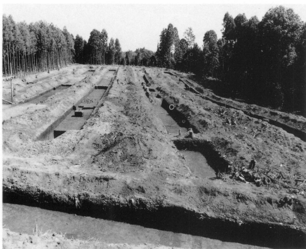
トレンチ設定状況
