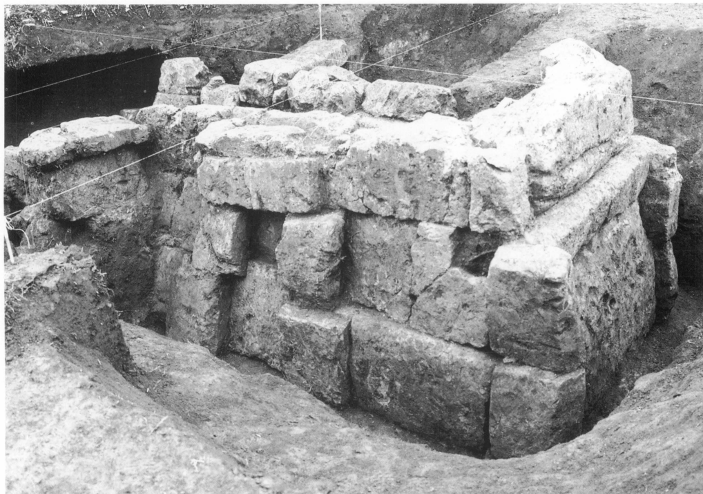
1.003号墳石室構築状況 北東より
