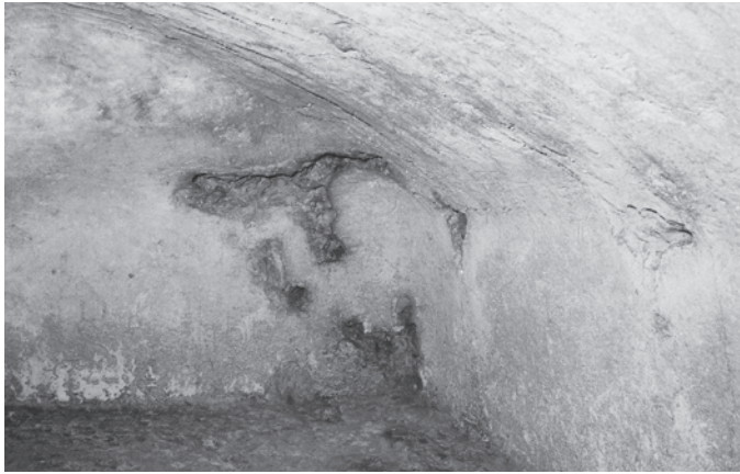
1. ST-006玄室左側壁と奥壁
