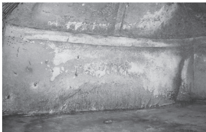
4. ST-007玄室左側壁
