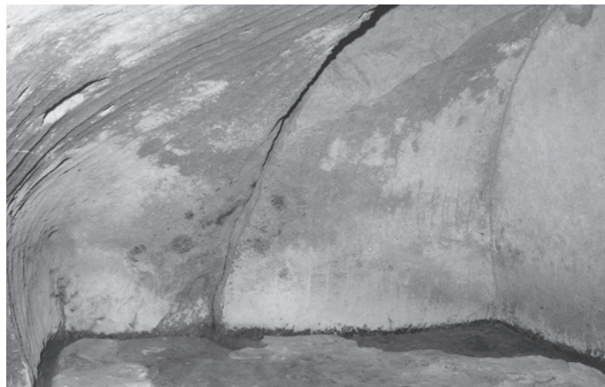
2. ST-008玄室左側壁
