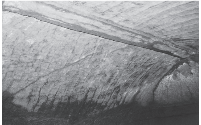
2. ST-009玄室天井（前壁側）
