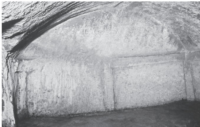
1. ST-010玄室左側壁
