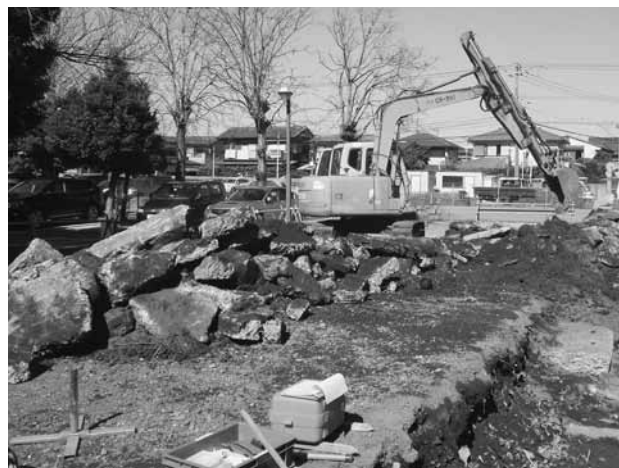
写真1 建築廃材の集積
