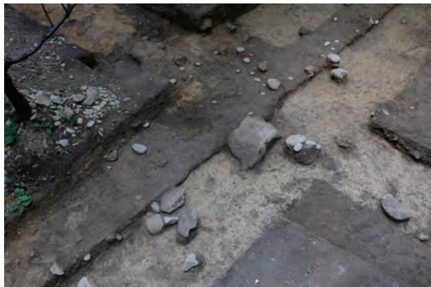
礎石の確認状況（令和 2 年度）
