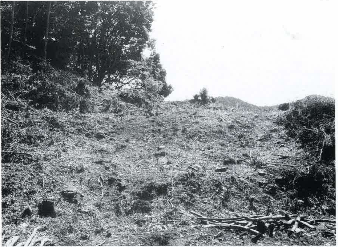
T-1 トレンチ草類除去後
