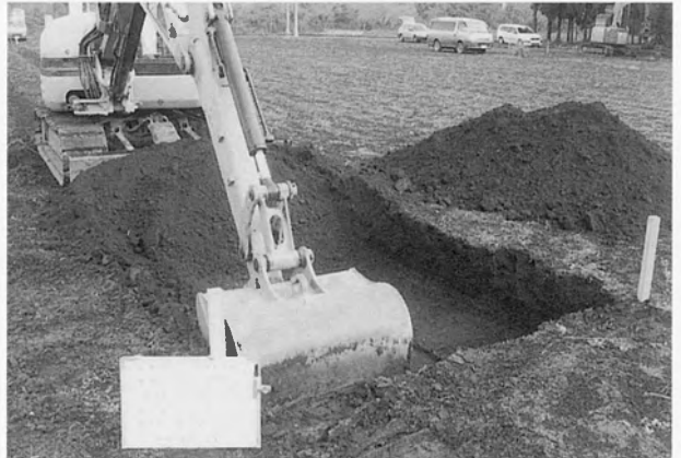
上層確認調査状況
