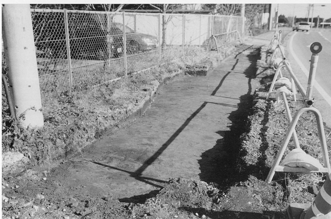
第2地点東側調査状況
