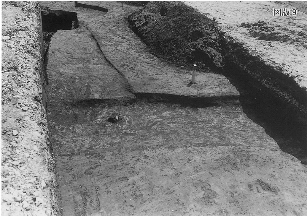
IV 009道路全景
