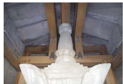
[写真2-17] 石廟内部応急処置後
