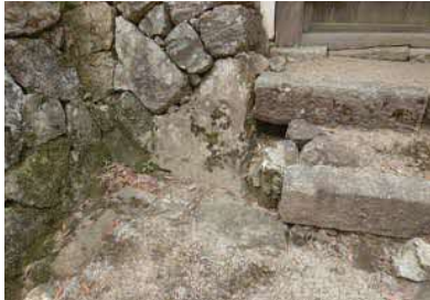
[写真 3-49] 排水路（門東から）
