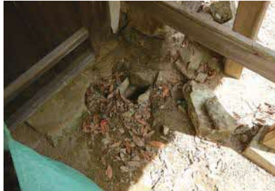
[写真 3-50] 排水路（門北西から）
