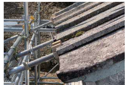
[写真2-15] 石廟屋根板石調整後
