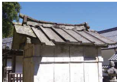
[写真2-14] 石廟屋根応急処置前
