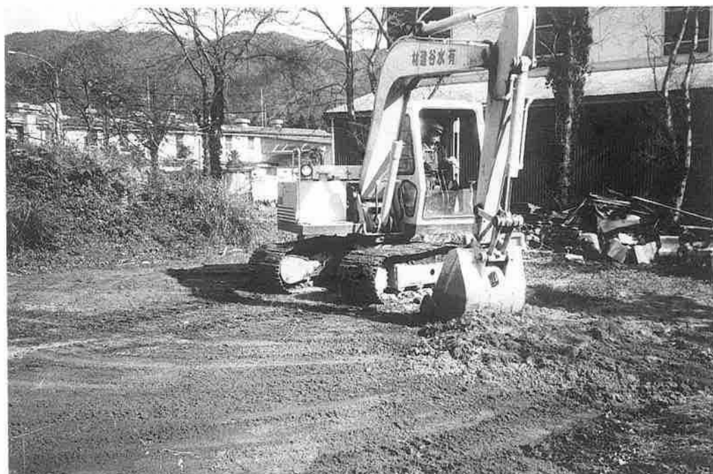
6. トレンチ埋めもどし作業
