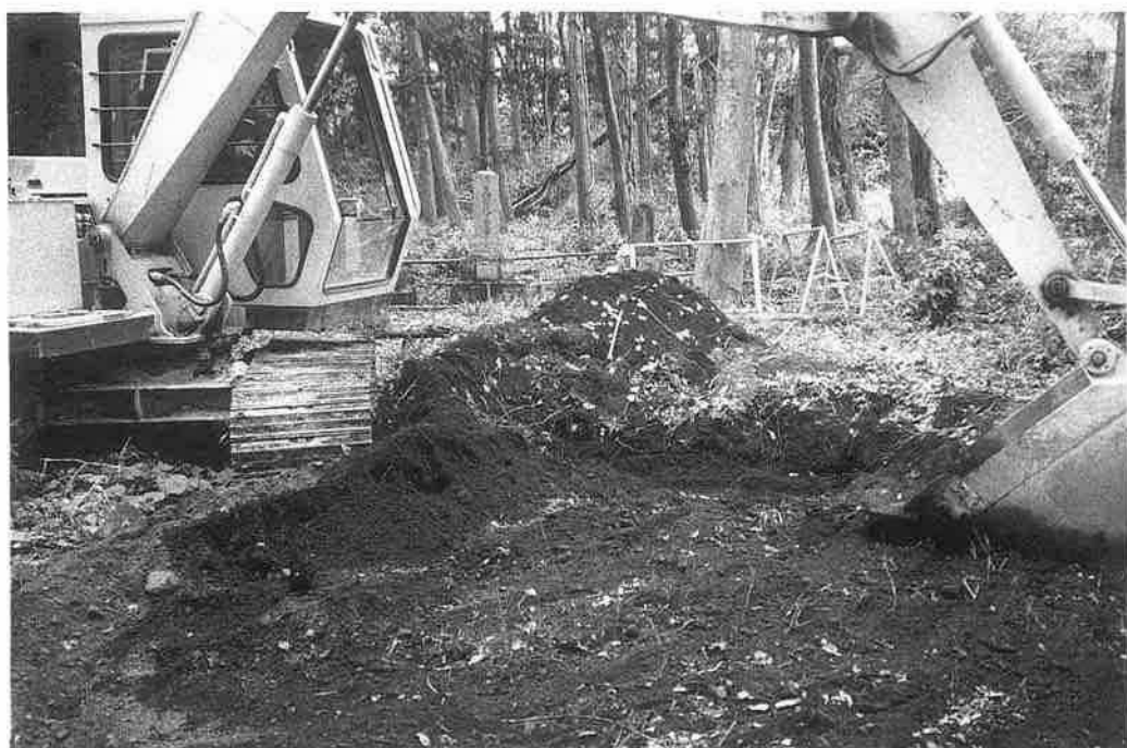
9. トレンチ埋めもどし作業
