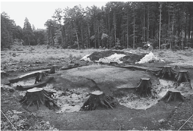
完了状況北から
