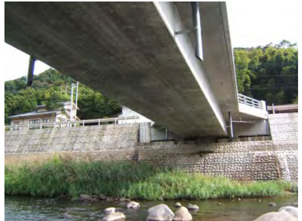
写真 50 下小竹橋下部
