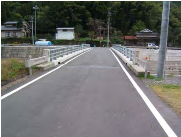
写真 49 下小竹橋橋梁
