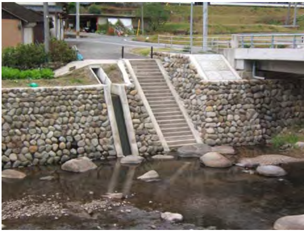
写真 45 河川護岸 (右岸)
