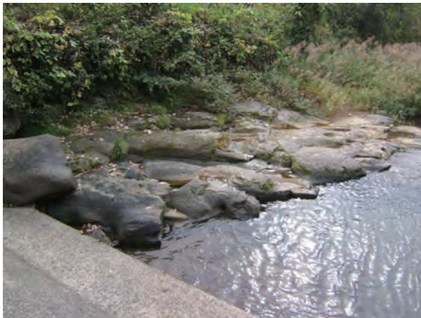
写真41 露出した凝灰岩
