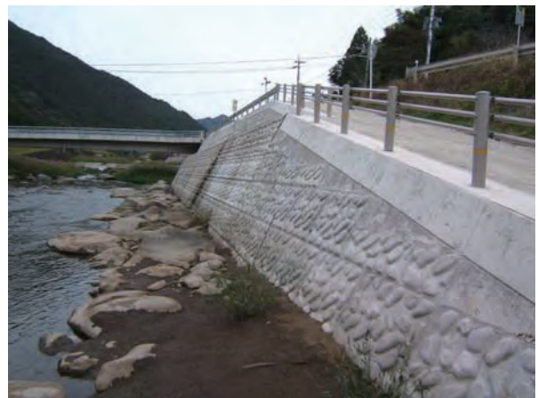
写真44 河川護岸（左岸）
