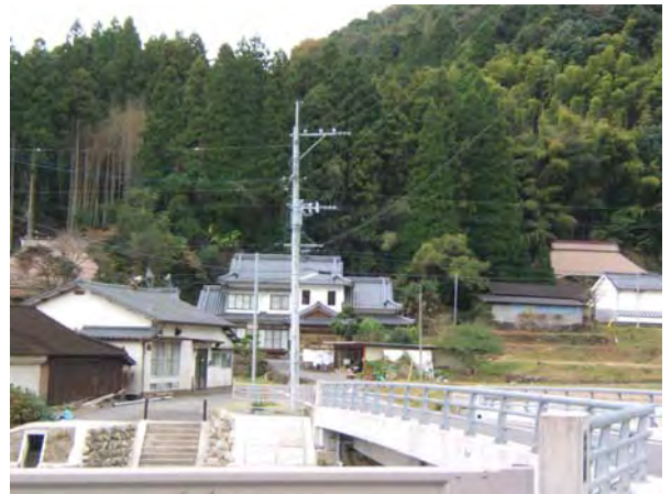
写真 48 電線と下小竹橋
