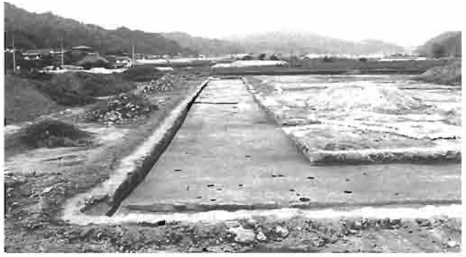
A区全景（南方向より）
