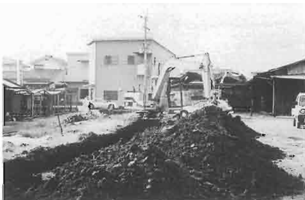
試掘調査状況
