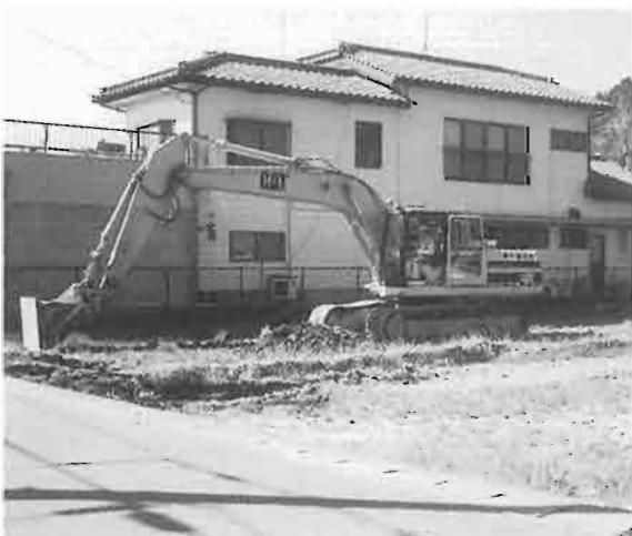
試掘調査状況
