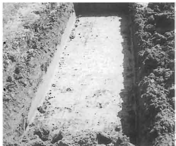
トレンチ完掘状況
