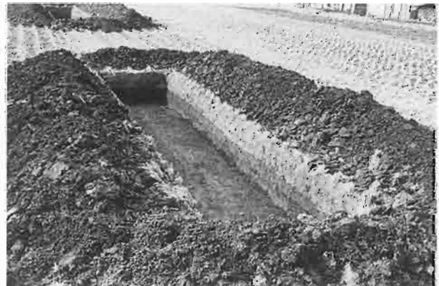
トレンチ完掘状況
