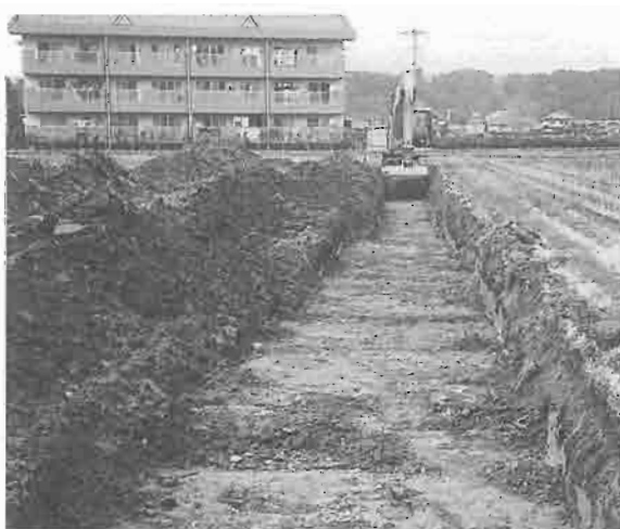
試掘調査状況
