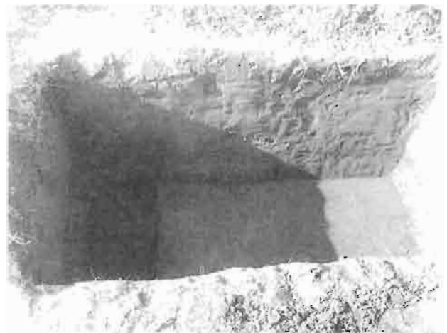
トレンチ完掘状況
