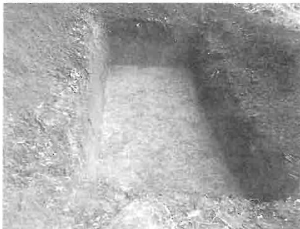
トレンチ完掘状況
