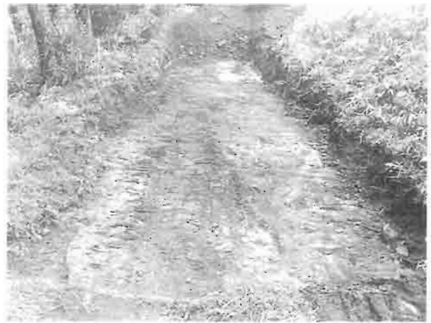
トレンチ完掘状況
