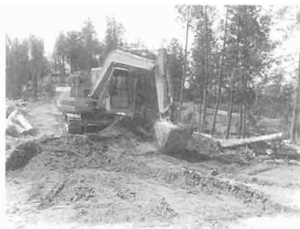
試掘調査状況
