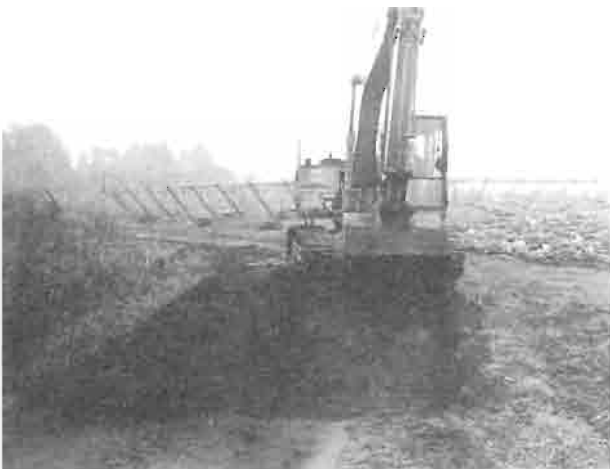
試掘調査状況
