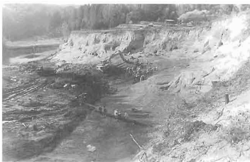
平島横穴墓群発掘調査作業風景 (南方向より)
