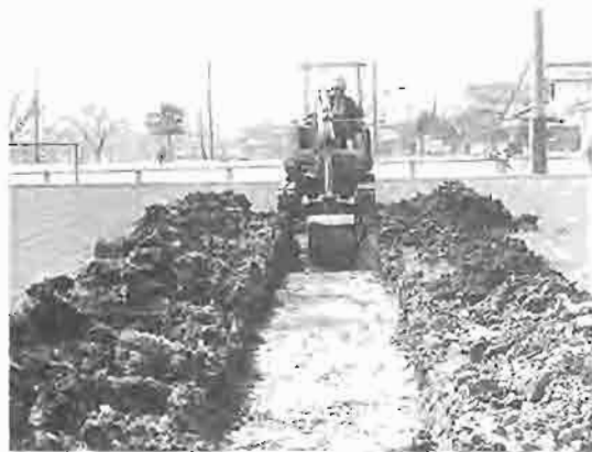
試掘調査風景写真
