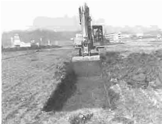
試掘調査風景写真
