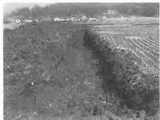
トレンチ完掘状況
