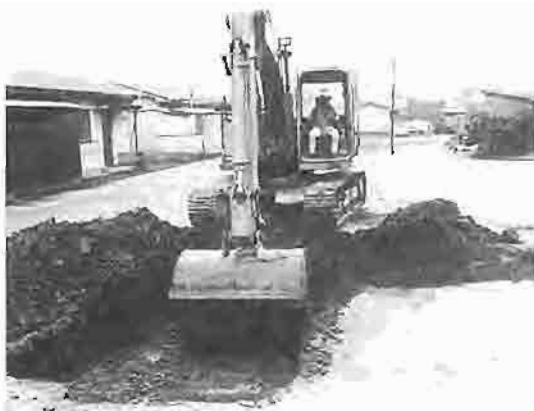
試掘調査作業風景
