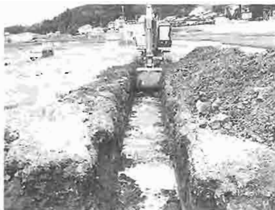
試掘調査作業風景
