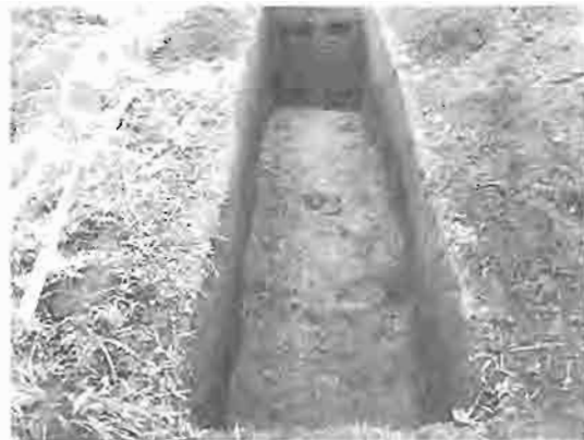
トレンチ完掘状況
