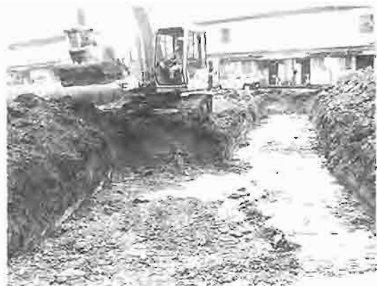
トレンチ完掘状況
