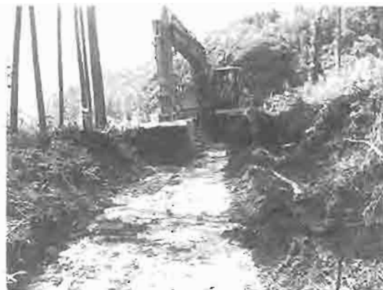
試掘調査作業風景
