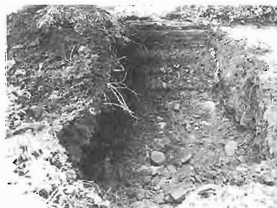
トレンチ完掘状況
