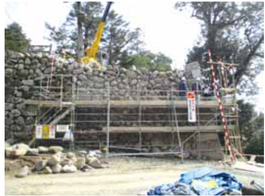
1工区石積み状況
