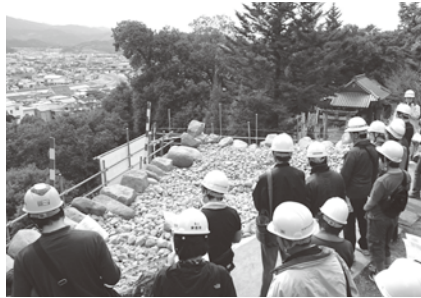
1工区（大手石垣）説明風景
