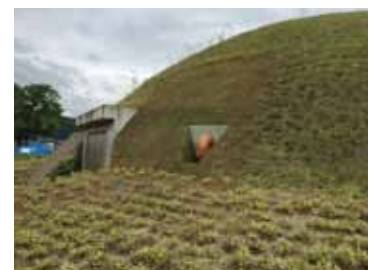
復旧工事完了状況
