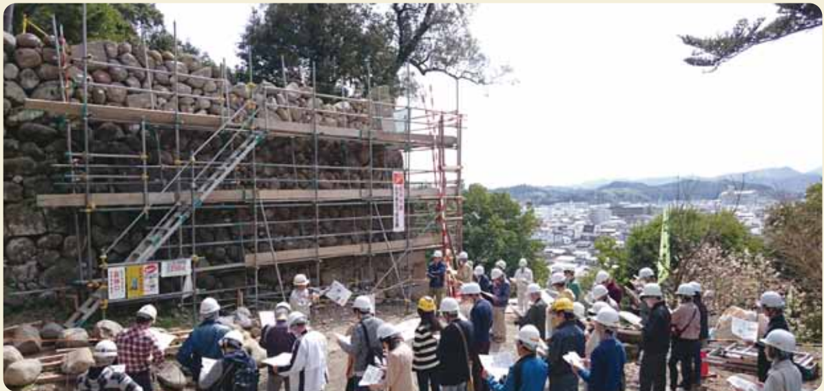
県指定史跡 永山城跡 災害復旧工事
