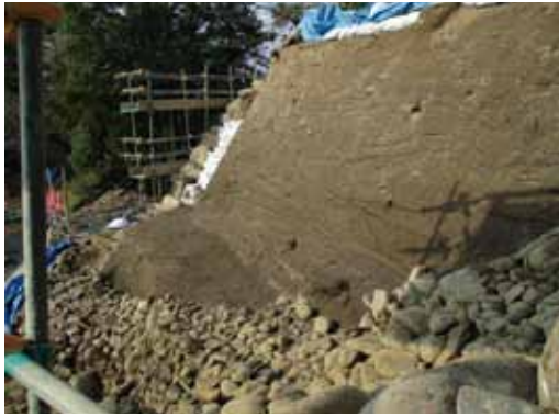
1工区背面盛土とグリ石（石垣10側から）
