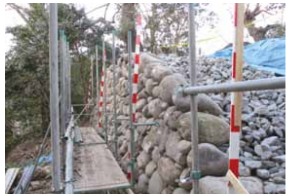
2工区石積み状況
