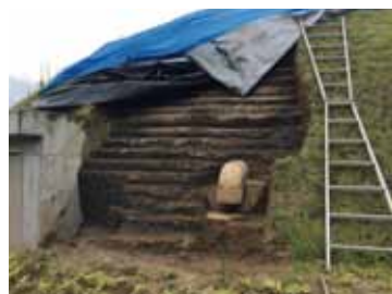
復旧工事施工状況
