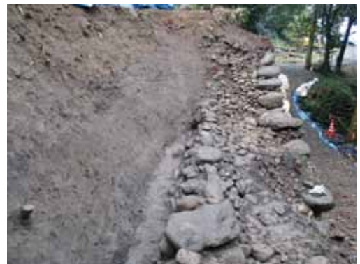
2工区「裏留め石」検出状況
