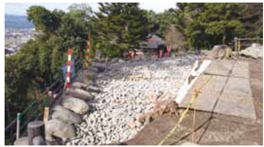
1工区グリ石列施工状況
