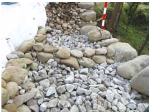
2工区グリ石列施工状況
