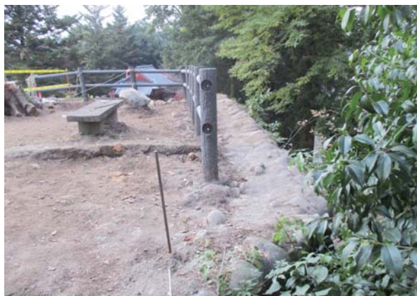
④石垣 8 上面のモルタル検出状況 1
