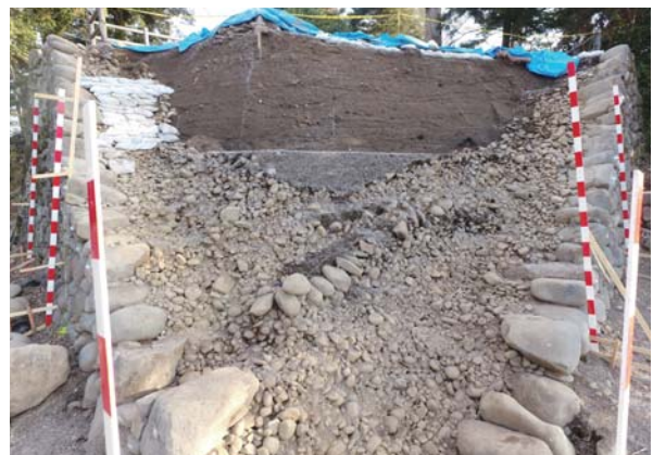
⑧石垣 10 と平行する裏止め石の列
