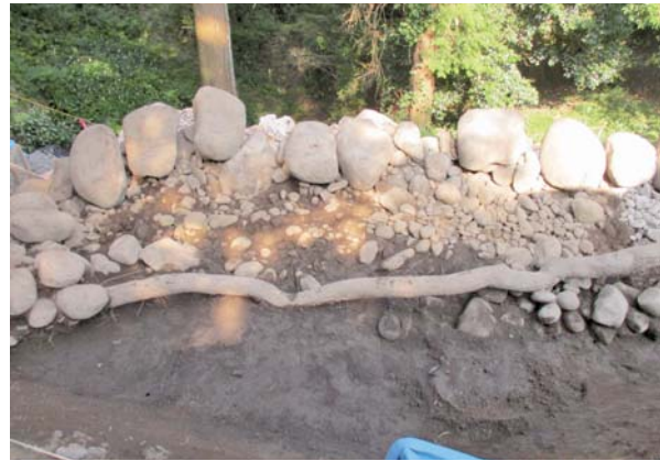
②裏止め石 石材も小さい
