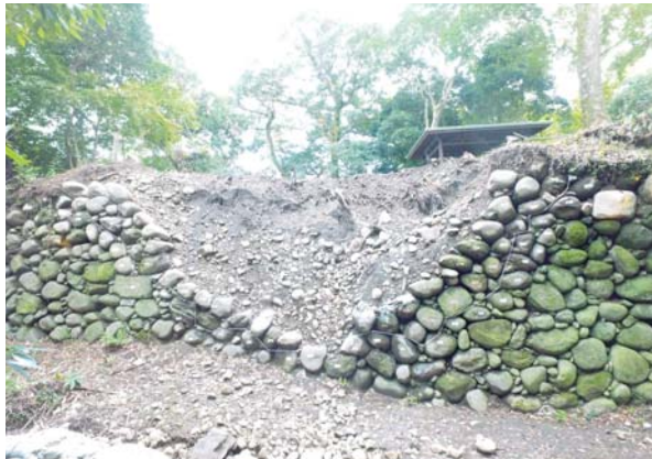
①解体前の状況
