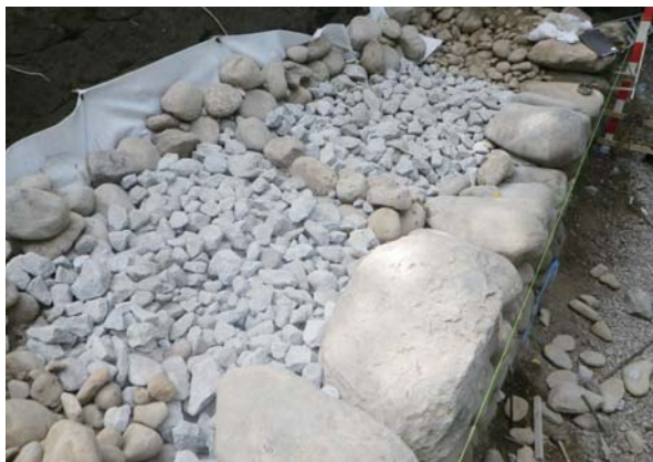
⑤石列施工状況
