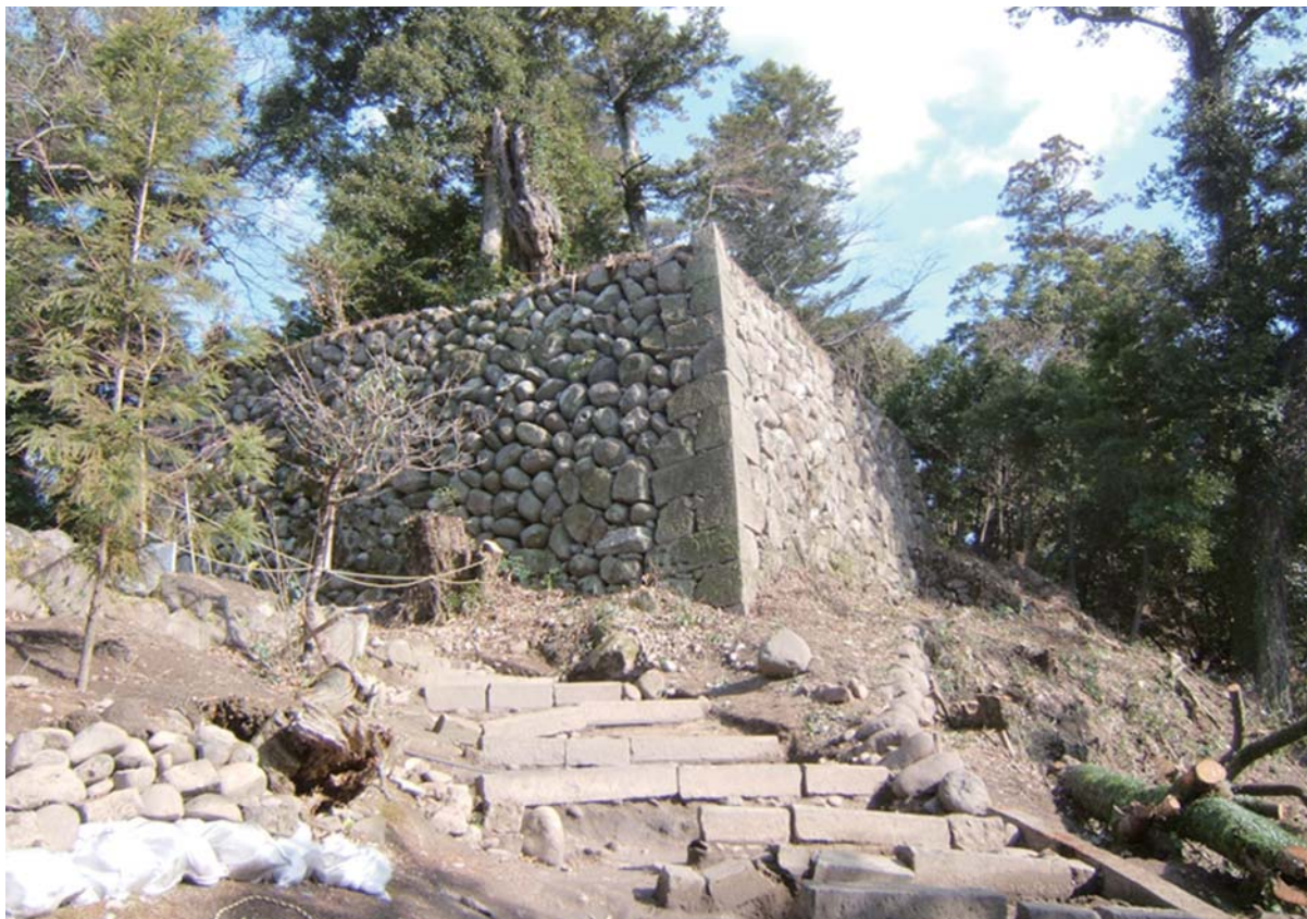
①石垣 9・10 出角部 被災前 (H 22)
