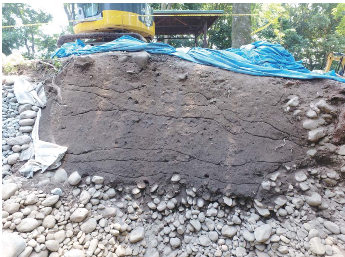
写真2 2-2工区背面土層写真
