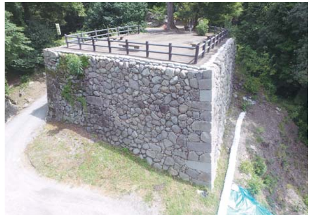
⑧施工完了状況
