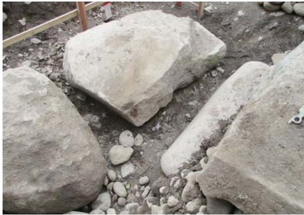
①角石根石検出状況 築石から遊離している
