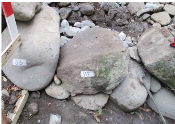
⑤ 93 据え直し完了
