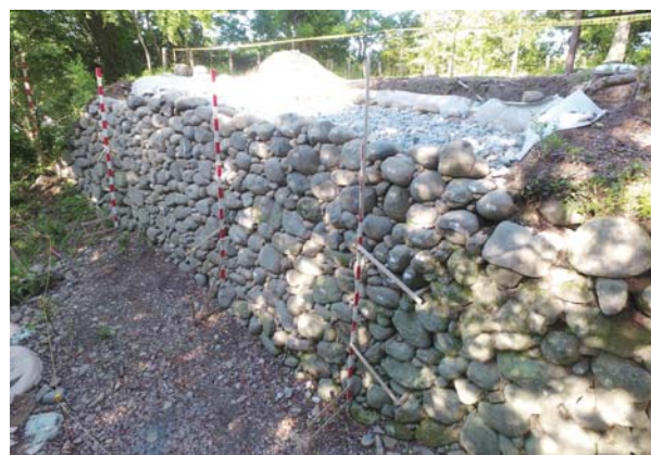
⑧積み上げ完了状況
