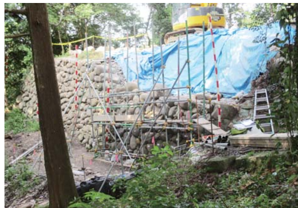
⑥積み上げ状況
