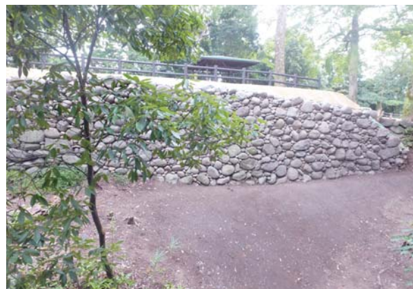
⑧天端施工完了
