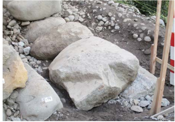
②角石根石の据え直し状況 2
