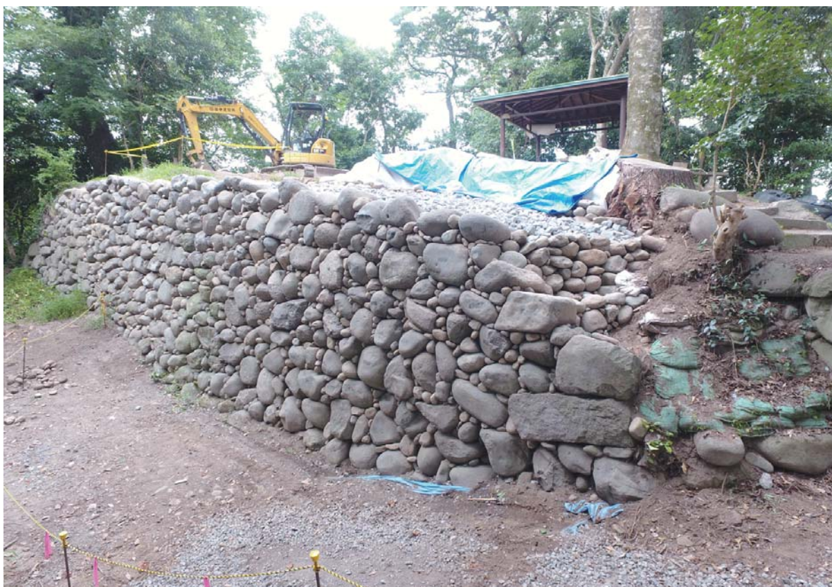
②石垣 2-2 積み直し状況
