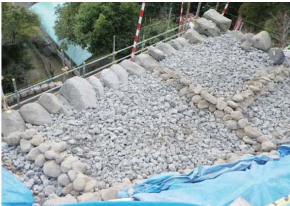
⑤円礫による石列施工状況 1
