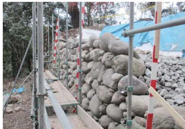
⑥積み上げ状況
