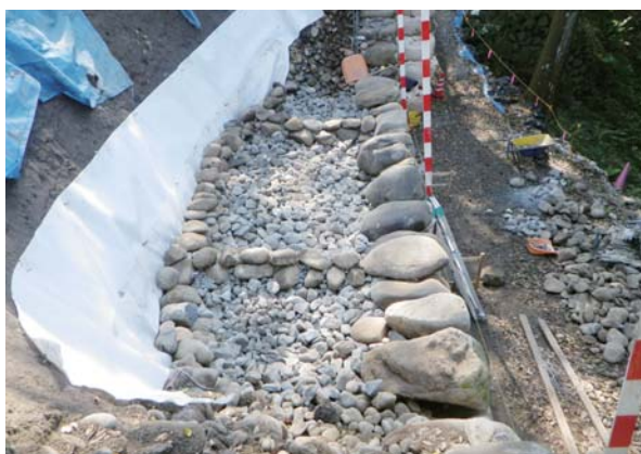
⑦石列施工状況
