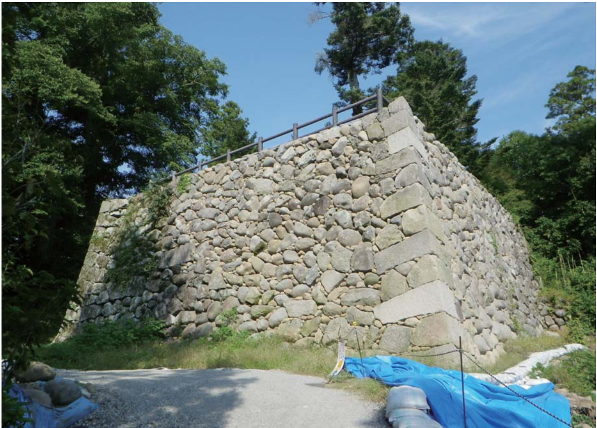
石垣 9・10 出角部 竣工
