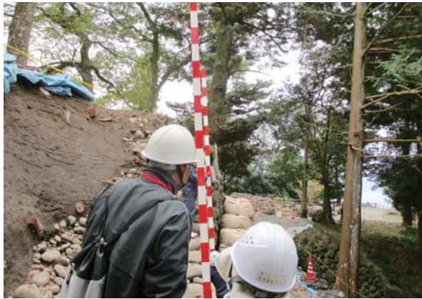
①高瀬委員による丁張り確認
