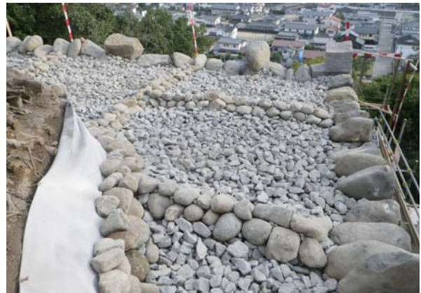
⑥円礫による石列施工状況 2
