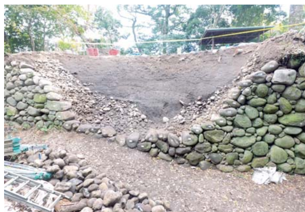
⑧解体完了
