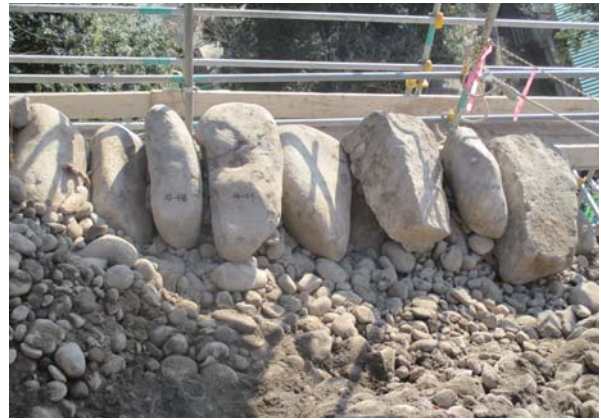
②控えの長い築石（石垣 10 の 5 段目）
