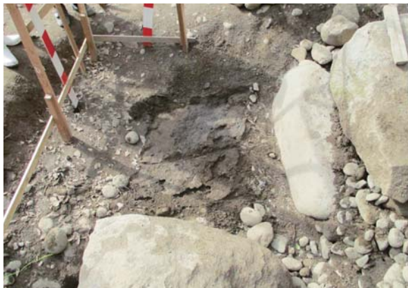
③根石の下の状況
