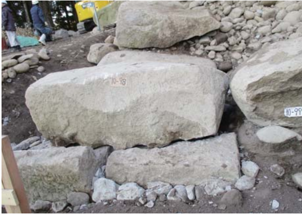
①角石根石の据え直し状況 1
