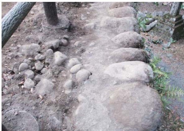
⑤石垣 8 上面のモルタル検出状況 2
