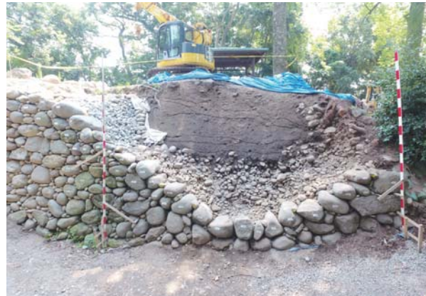
④解体完了
