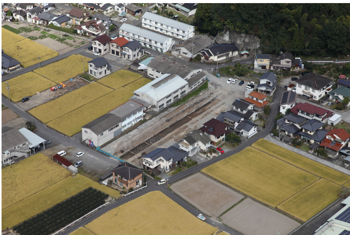
調査地全体写真（南東から）
