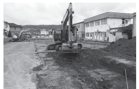
写真1 機械作業風景
