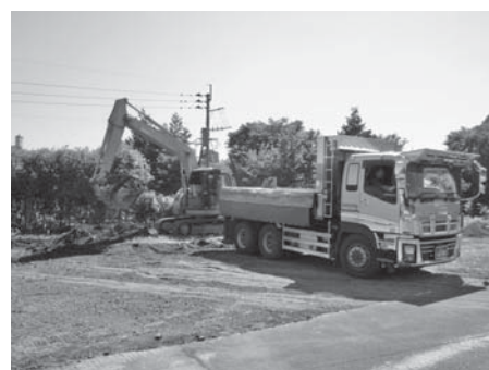
写真1 重機使用状況
