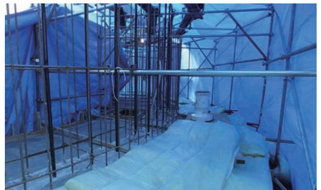
冬季のコンクリート打設のためシートで覆って温度管理を行った。
