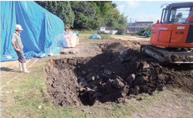
2次調査で判明していたとおり、古墳南東側には地下室付き民家跡地（P 63）に産業廃棄物が埋設されていた。
