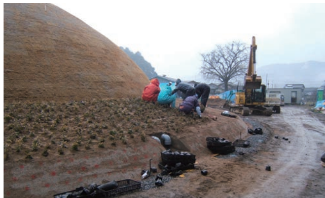
相互の根の広がりを防ぐため、テラス部との境に根防止板を設置してから施工。
