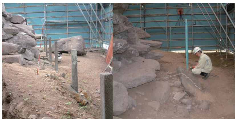
写真 2-13 フェンス撤去工事
