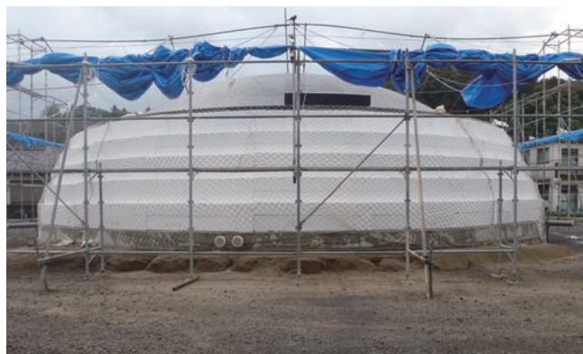
荷重軽減のための最下層の軽量盛土。
