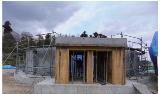
壁部の脱枠後の姿。入口部は屋根工事後に脱枠。
