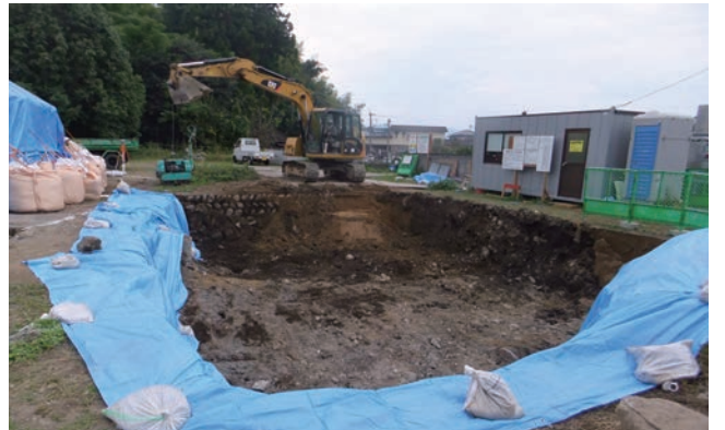
産業廃棄物の埋設は地下 1.2 m に及んでおり、旧隣接地との石垣付近までの 170 m 2 に及び、これらを良質土に入れ替えた。
