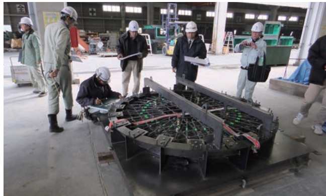
屋根材を受け止める天井中心の円盤部
