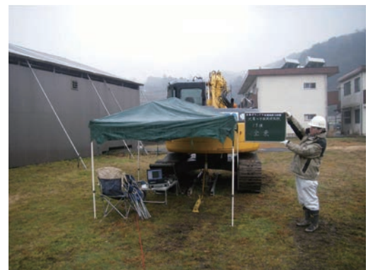
写真3-7 地耐力試験風景
