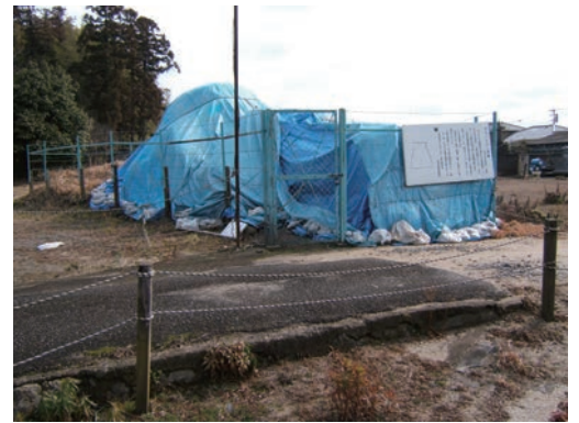
写真 2-5 仮設覆屋施工前
