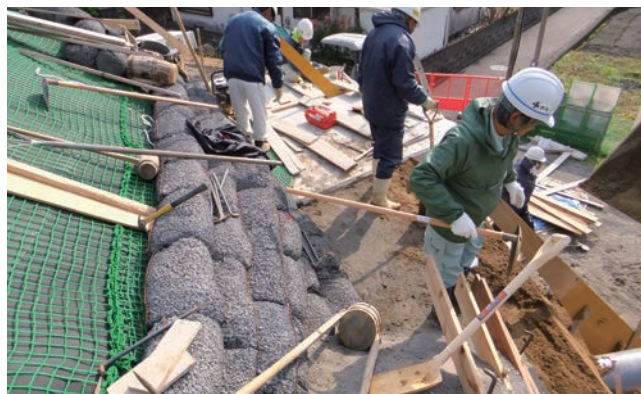
砂利層を一定の厚みで立ち上げつつ施工を実施。
