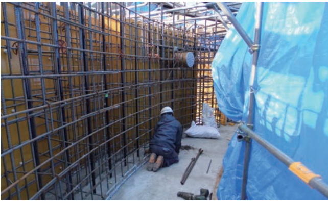
③ 基礎コンクリート打設風景
