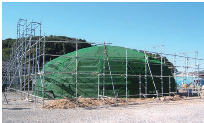
砂利層を設置するためのネット。
