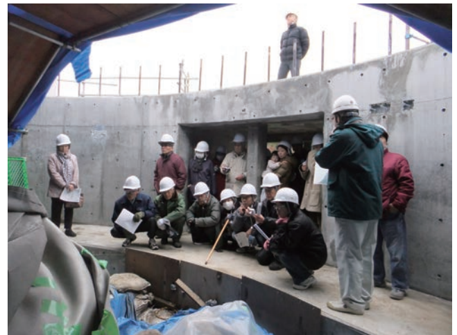
写真5-4 工事現場説明会②
