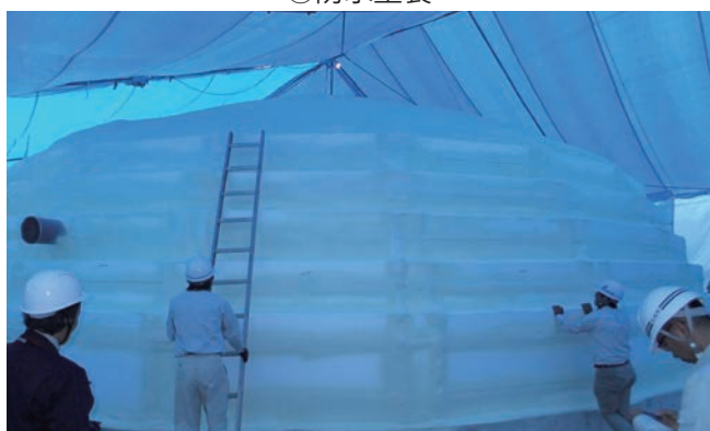
軽量盛土のため上層に発砲ウレタンを塗布。周囲への飛散防止のためシート養生。
