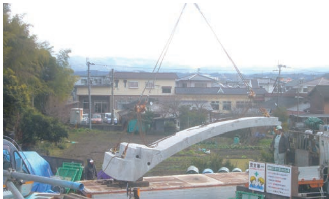
完成した屋根材をトラックで運搬しクレーンで設置。
