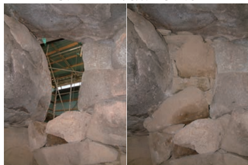
写真 2-12 間詰工事 (左：着工前、右：竣工後)
