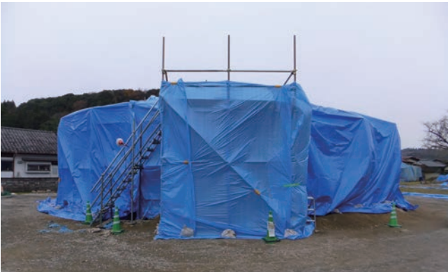
ブルーシートによるコンクリート温度管理の養生風景
