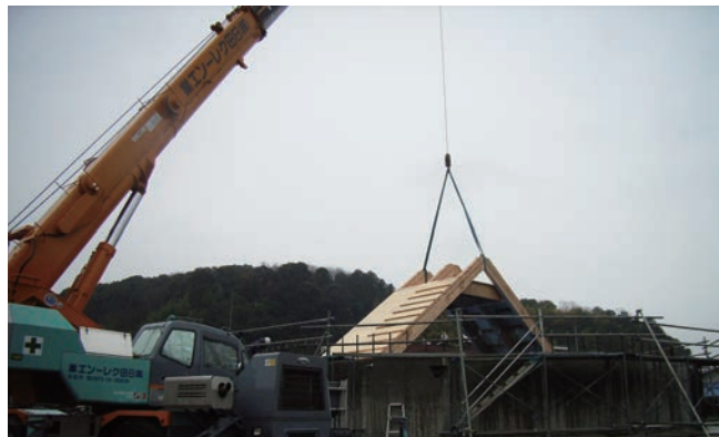
完成した支保材を古墳に影響がないように慎重に設置。
