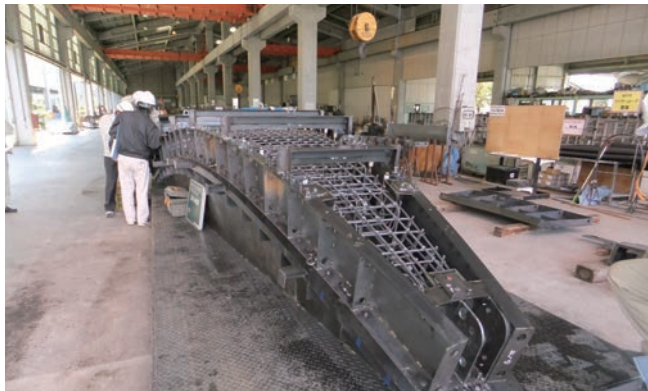
屋根材の配筋を行い型枠をはめてコンクリート打設を実施する。 20枚ある屋根材の1枚。
