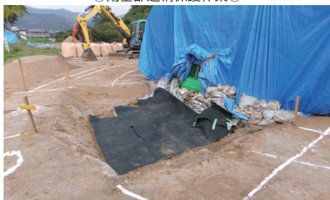
上部に地盤改良土を流し込むため、露出する石などに触れないよう厚さ 10 mm の不織布で覆う。
