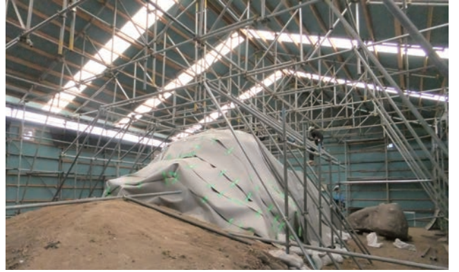
ウレタンシートで養生を行い、単管で骨組みして、コンパネとブルーシートで簡易覆いを設置した。
