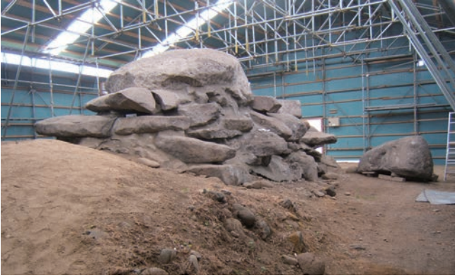
施工前は仮設保護施設に覆われていた。
