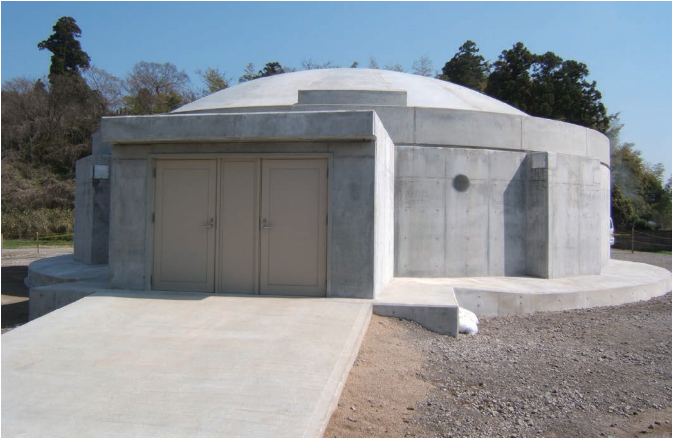
③屋根設置完了並びに脱枠の状況
