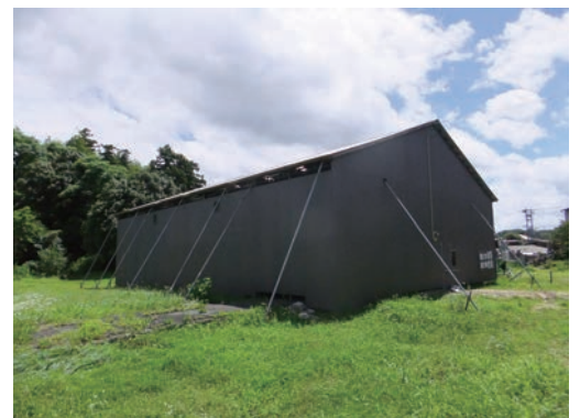
写真 2-7 仮設覆屋完成
