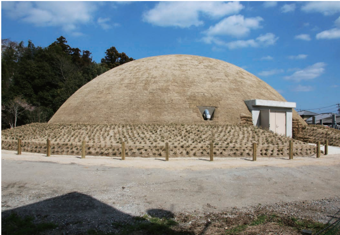
①施工完了①
