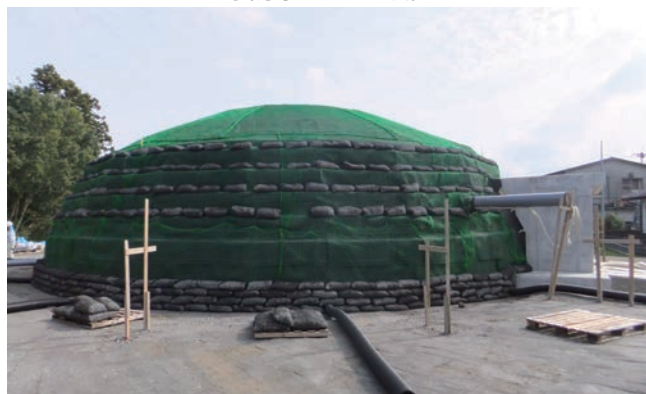
キャピラリーバリアのため、砂利土嚢につめて躯体の段に沿って設置。同時にマウンドを浸透してくる水の排水工事も実施。
