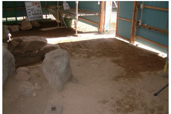
⑥ 1 トレンチ埋め戻し完了後
