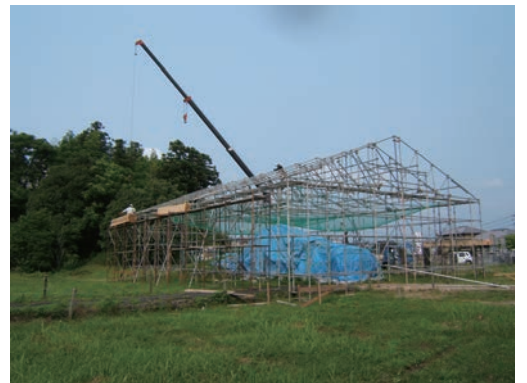
写真 2-6 仮設覆屋設置工事
