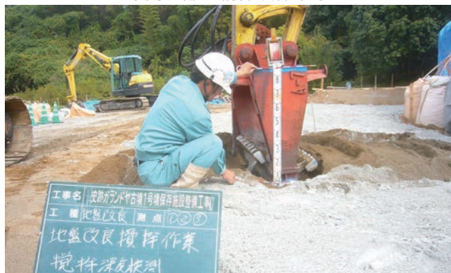
改良剤を地盤土と攪拌するため、遺構面等を損傷することがないように深度検尺を行って一定に保った。
