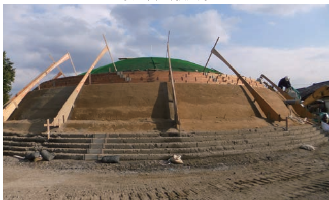
15 cm単位で撒き出し転圧を加えた互層構造。半分ほど完成。円形を保持する型枠を設置してマウンド形状を維持。
