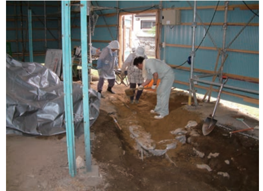
写真3-9 1トレンチ調査風景
