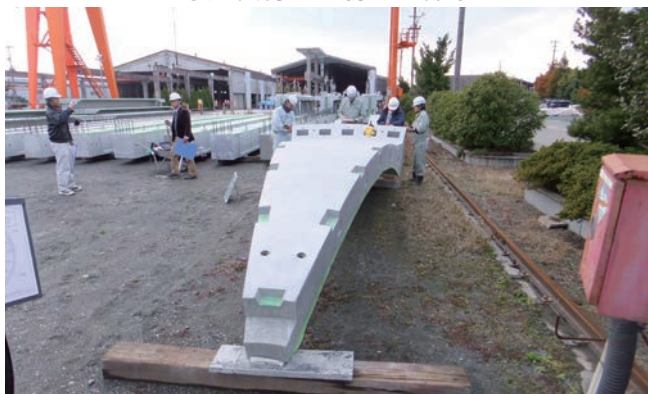
型枠から脱枠している状態。
