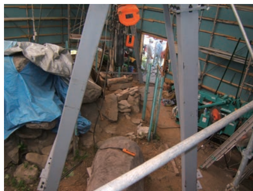
写真 2-10 天井石移動完了後
