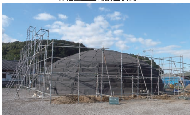
②軽量盛土材設置状況
