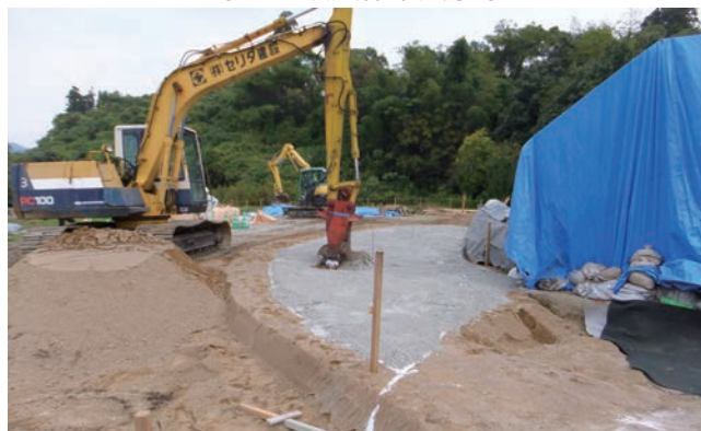
機械による攪拌作業風景
