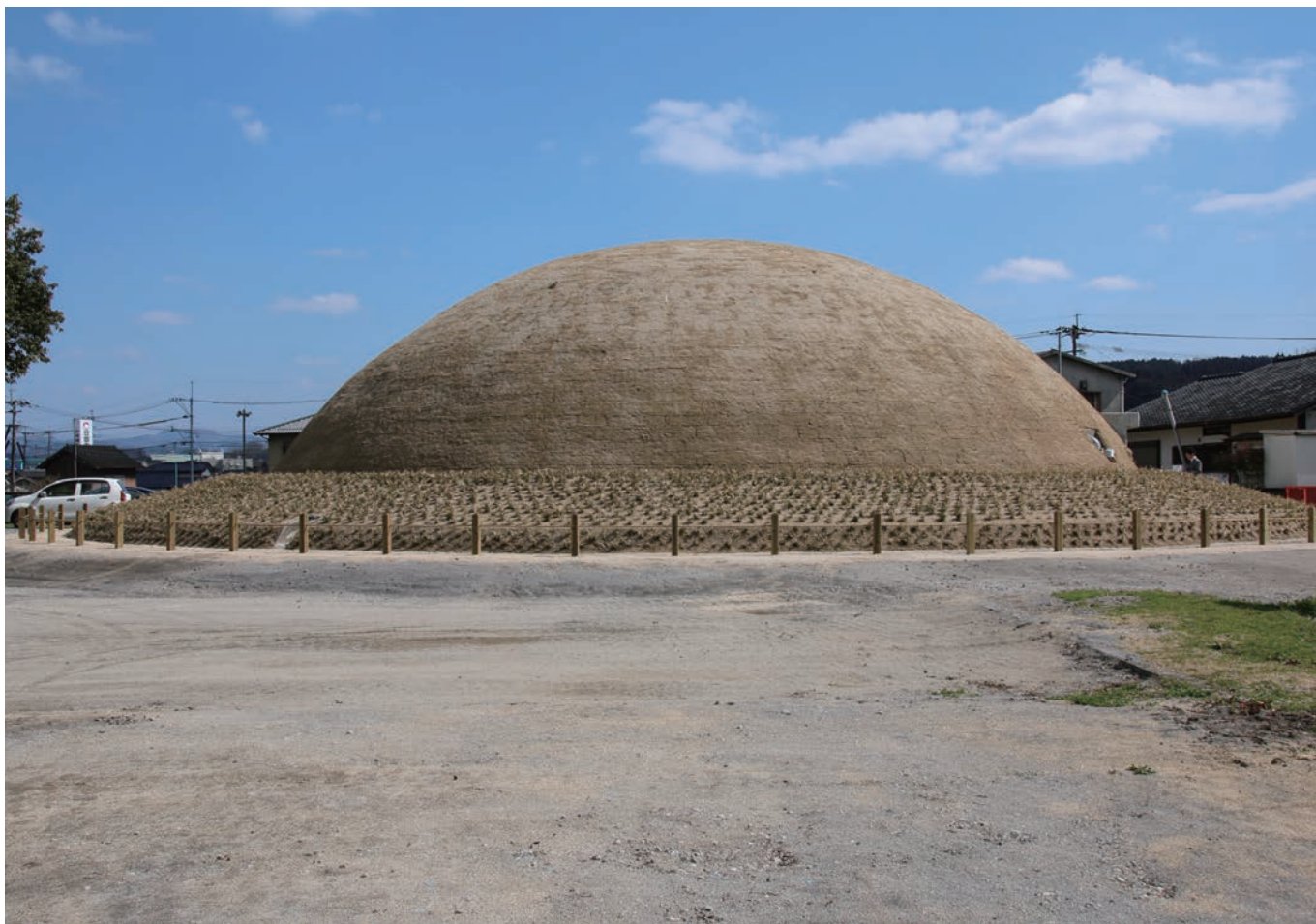
②施工完了②
