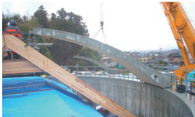
設置作業風景
