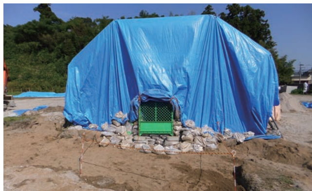
施工に際して遺構を損傷することのないよう真砂土で一旦覆う。
