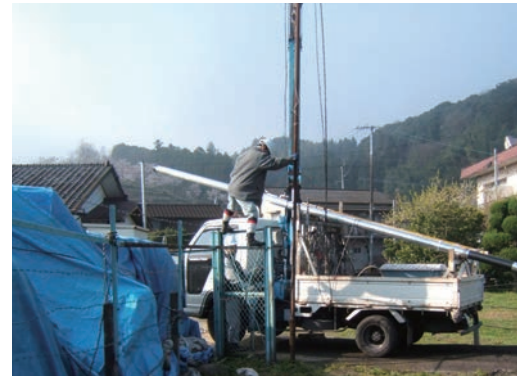
写真 2-4 アンテナ移設工事
