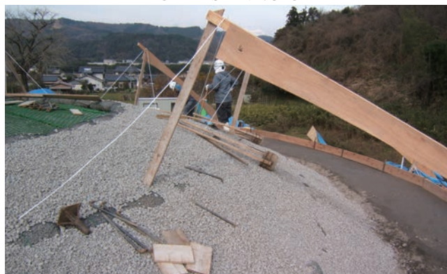
砂利土嚢は、壁面部の急勾配面で用い、屋根部分の緩勾配部分は直接敷き均した。
