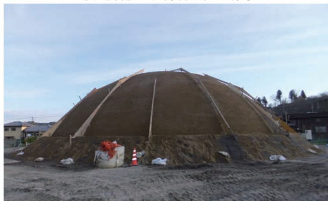
鉦砕成分の下層盛土では地被植物が育ちにくいいため、上層に植栽用の客土を行って土羽打で固めた。
