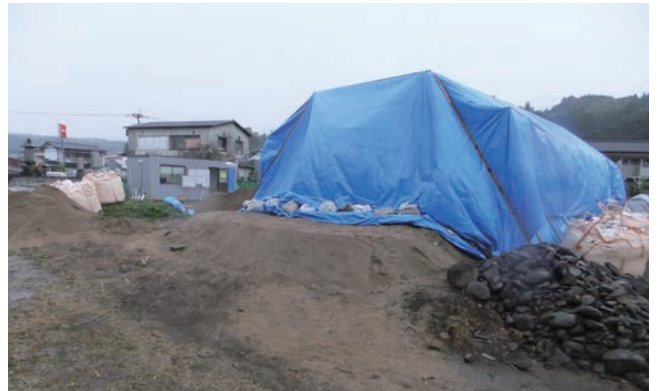
盛土撤去後は真砂土で保護を行った。この箇所は遺構保護のため周囲より 50 cm 基礎が高くなる。
