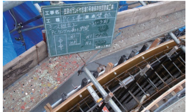
コンクリート打設前の配筋と型枠の状況。
