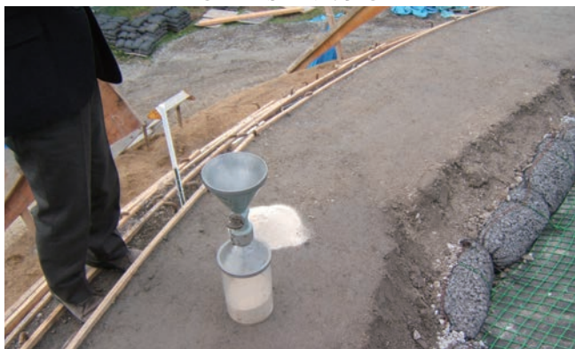
施工した盛土については8層3箇所ですり置換試験を実施し、所定の転圧を達成しているか確認した。
