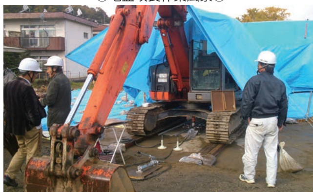
地盤改良後に平板載荷試験を行い、設計荷重に対する地盤反力を有していることを確認した。
