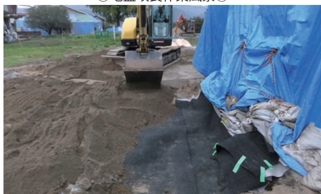
遺構残存が明らかな前庭部は別箇所でも攪拌した改良土を重機で尽力で上から被せた。
