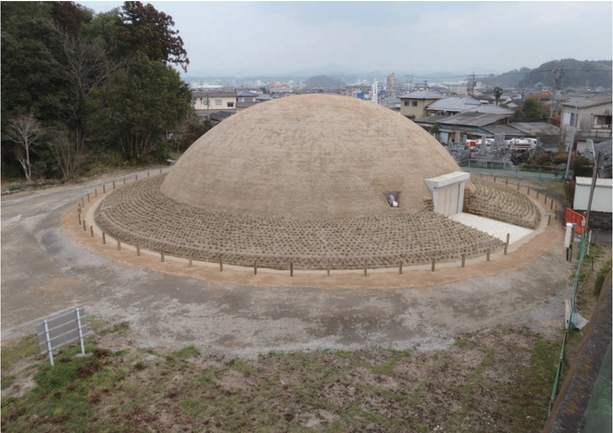
完成後の1号墳保護施設
