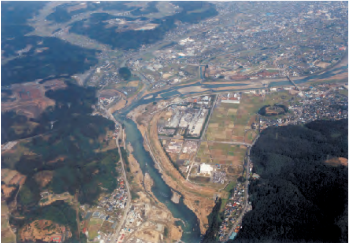
徳瀬遺跡遠景（西から）
